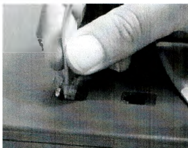
Рисунок 2-6 Установка сенсорных кабелей
