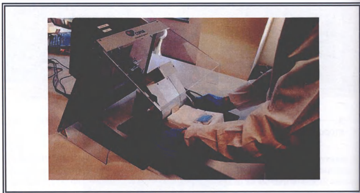
Рисунок 8.14 Установка рабочей площадки, конфигурация с устройством C-Tracer
