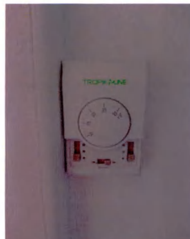
Рисунок 10.1. Пульт управления тепловой завесой.
