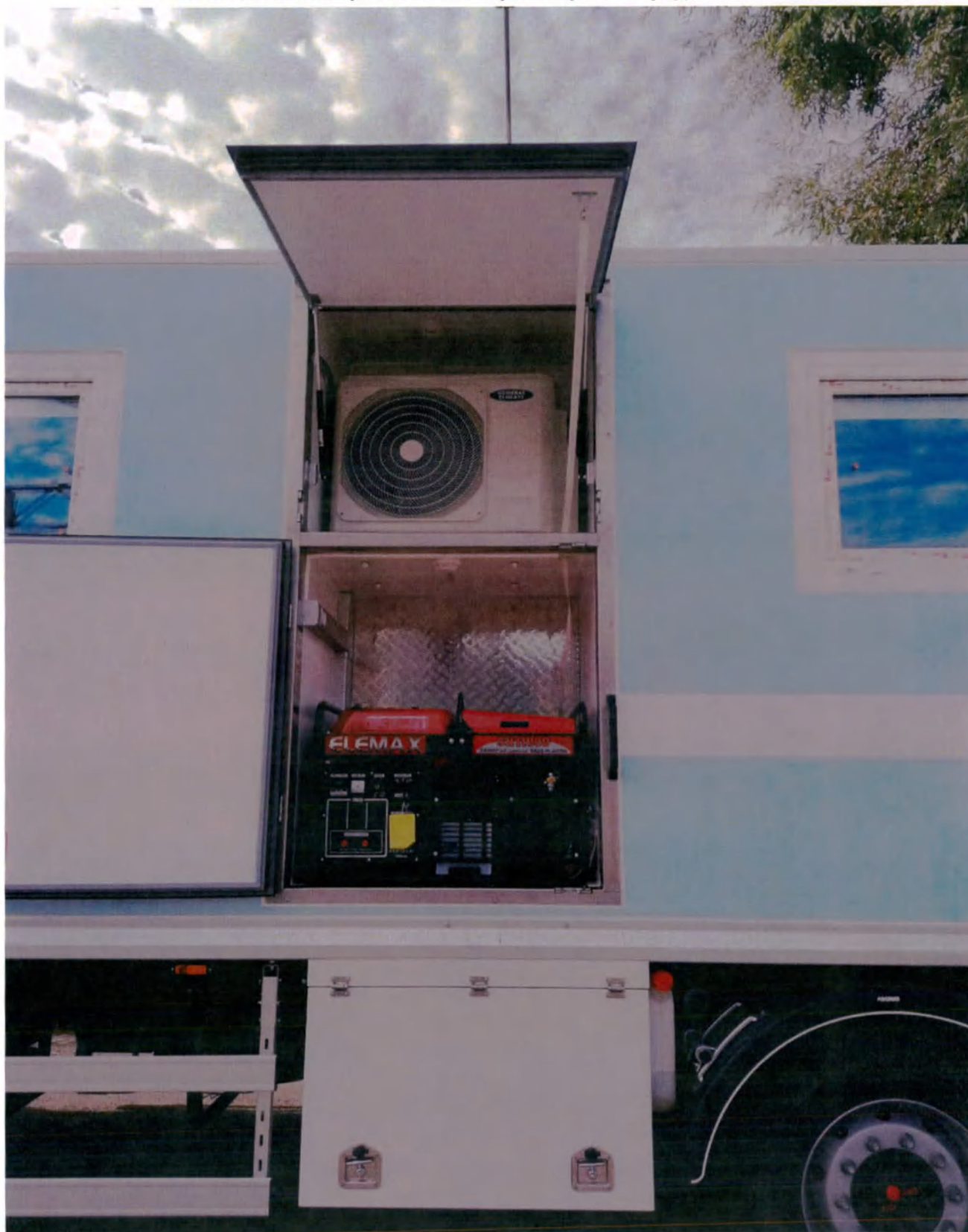
Место проведения съемки: Московская обл., г. Жуковский, ул. Кооперативная, д. 10
