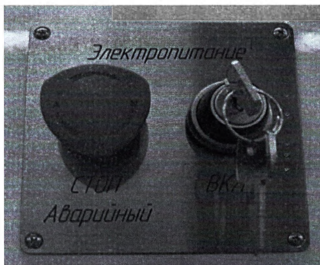
Рисунок 3 – Маркировка выключателя электропитания и кнопки аварийного обесточивания бокса
