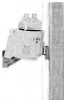
Рисунок 3.3 – Установка увлажнителя
