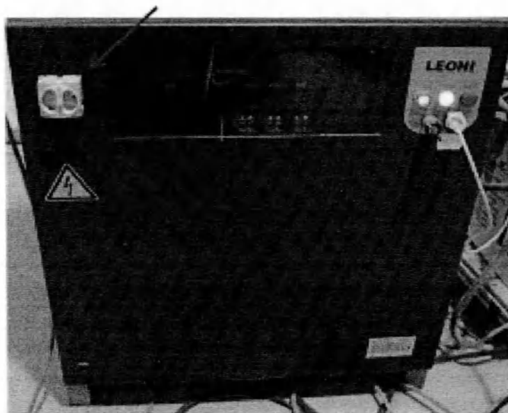
Рисунок 44. Выключатель питания на шкафу электрооборудования роботизированного манипулятора
