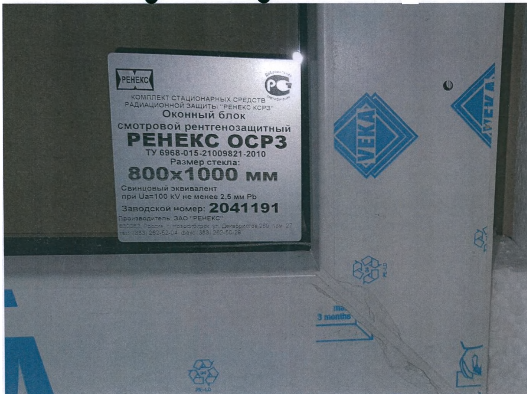
Фотография 76 – Окно рентгенозащитное, ЗАО «Ренекс» и маркировка
