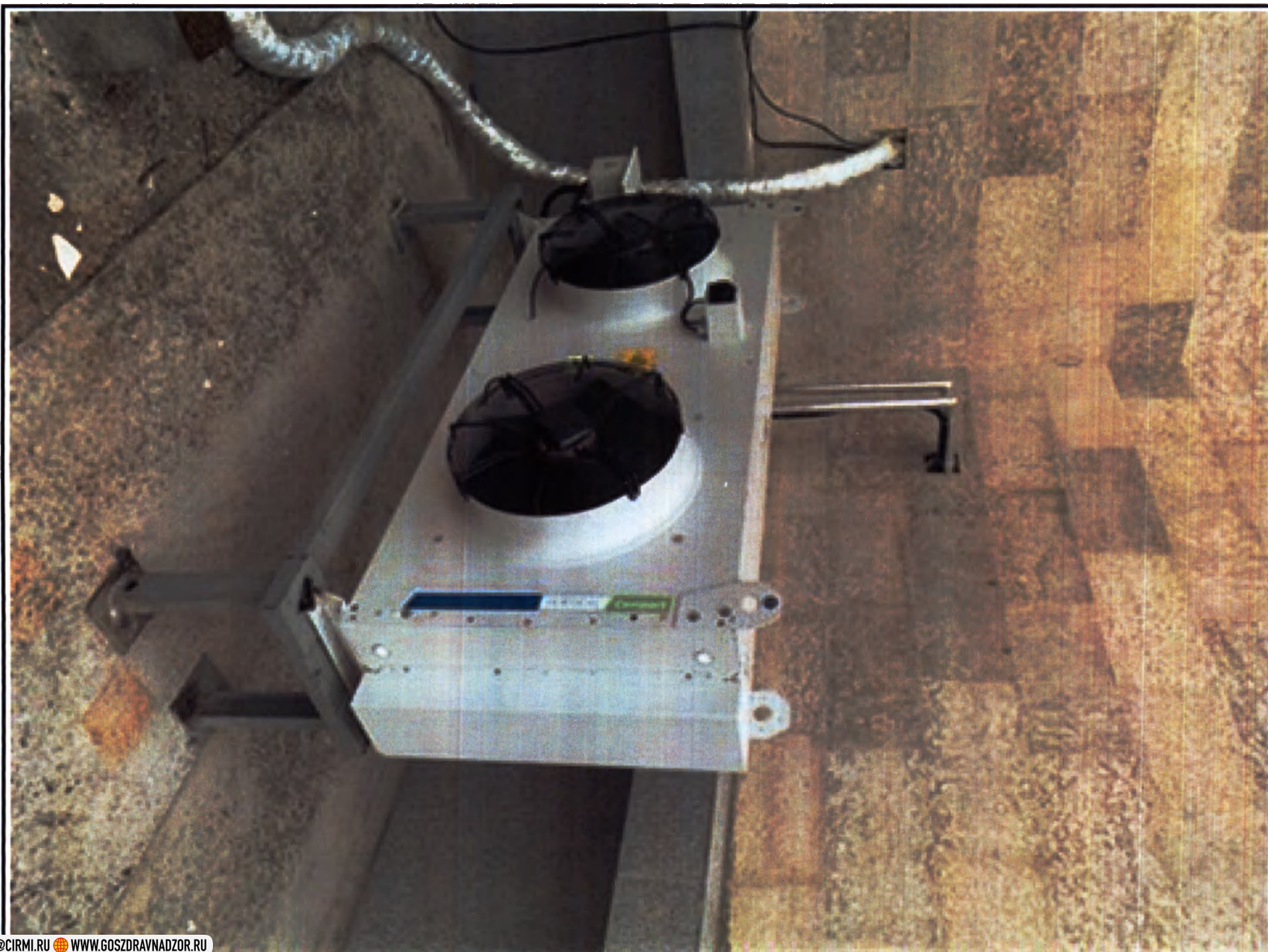
53. Система охлаждения компонентов МР томографа и рециркуляции воздуха в процедурной комнате (не более 20 шт.).
