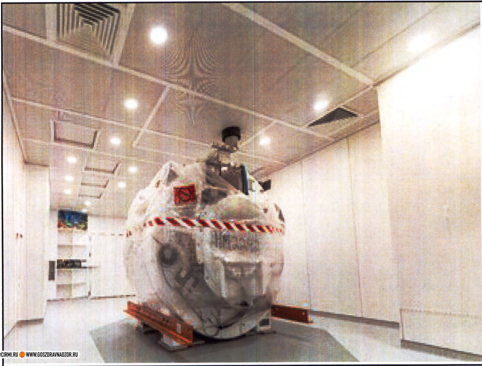
34. Устройство для защитного экранирования помещения (Клетка Фарадея).
