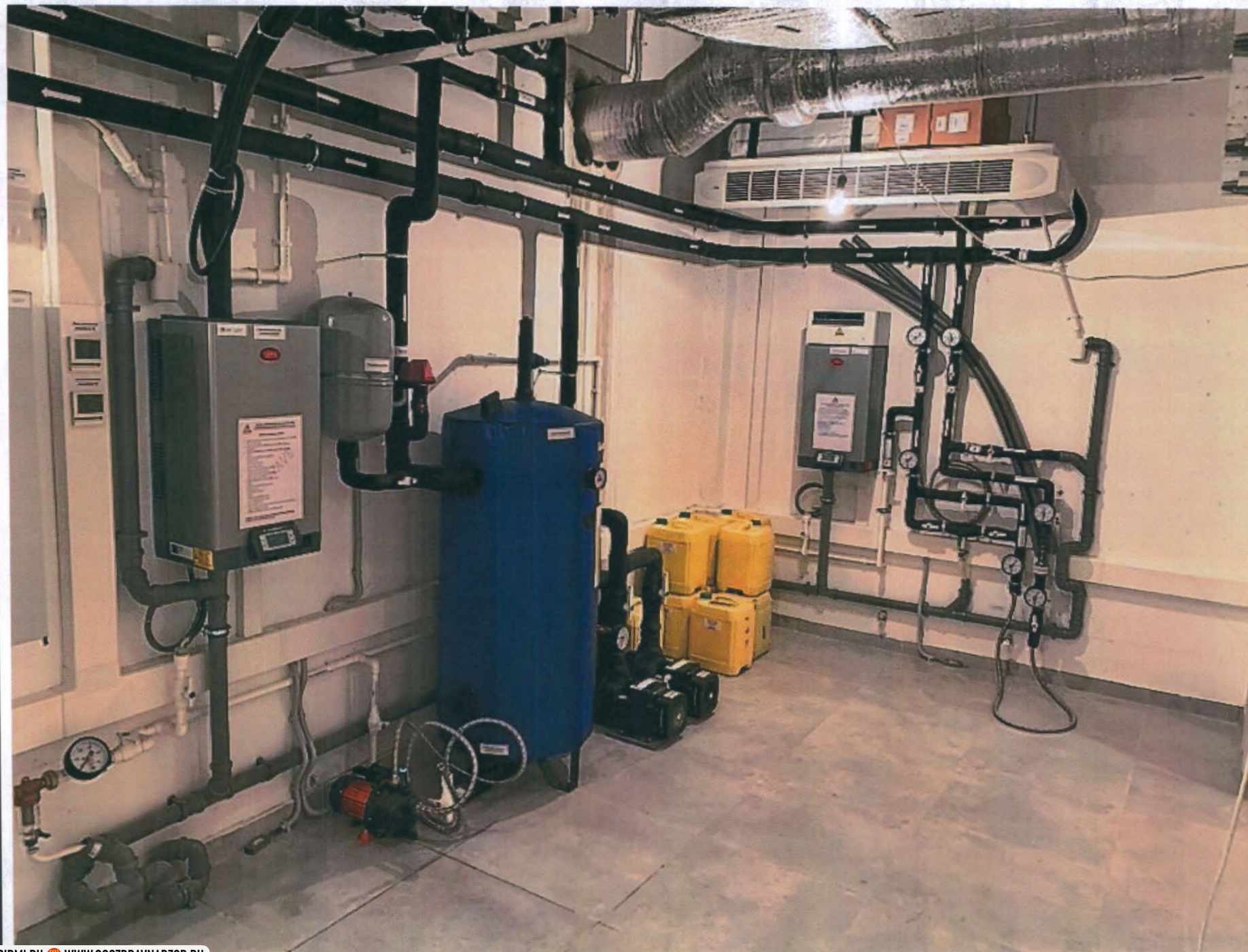
51. Система охлаждения компонентов МР томографа и рециркуляции воздуха в процедурной комнате (не более 20 шт.).
