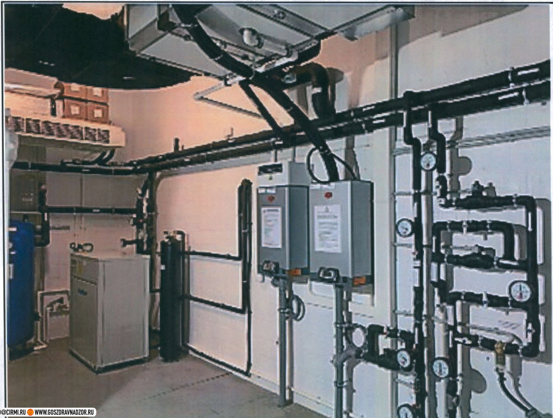
51. Система охлаждения компонентов МР томографа и рециркуляции воздуха в процедурной комнате ( не более 20 шт. ).
