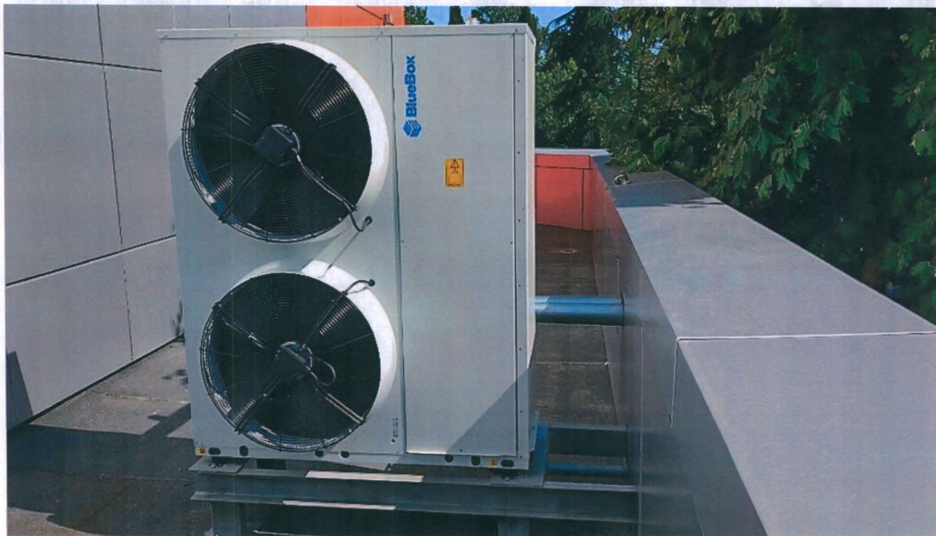
51. Система охлаждения компонентов МР томографа и рециркуляции воздуха в процедурной комнате (не более 20 шт.).
