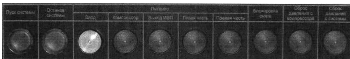
Рис. 3.8. Включен рубильник QS1 шкафа ввода, со шкафа ввода подаётся питание (далее – включен ШВ).
