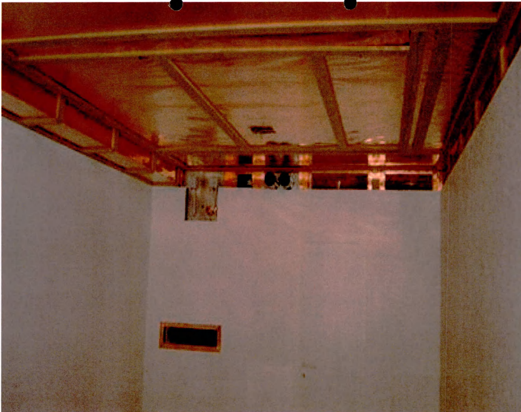
21. Кабина радиочастотная для защитного экранирования помещения.
