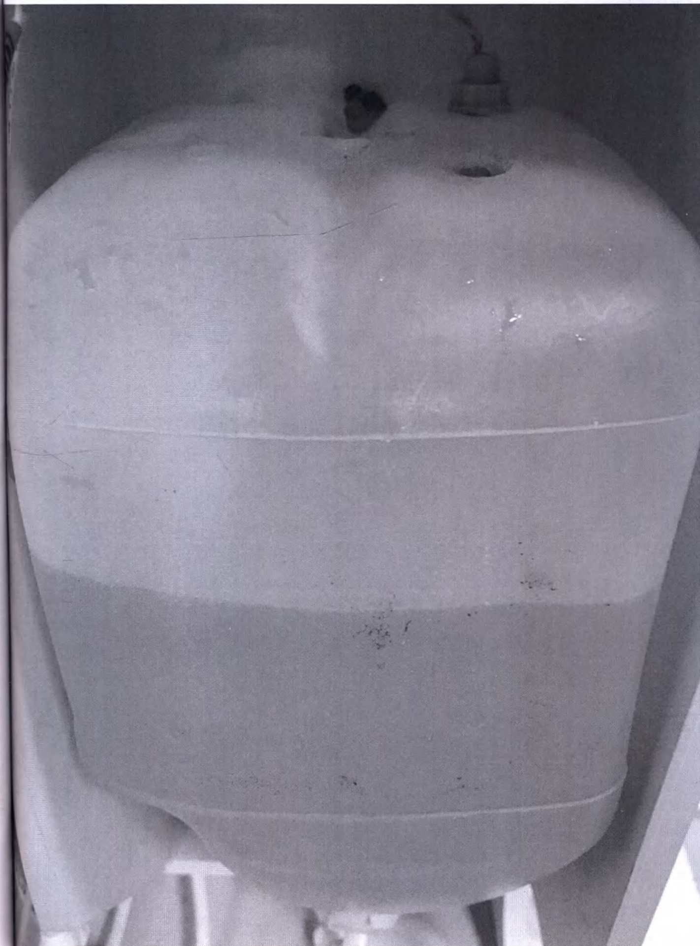
Изображение 11. Накопительная емкость с датчиками уровня воды для изделия «Установка очистки воды многоступенчатая «Aqua SmarT», с принадлежностями по ТУ 28.29.12-003-45929495-2018».
