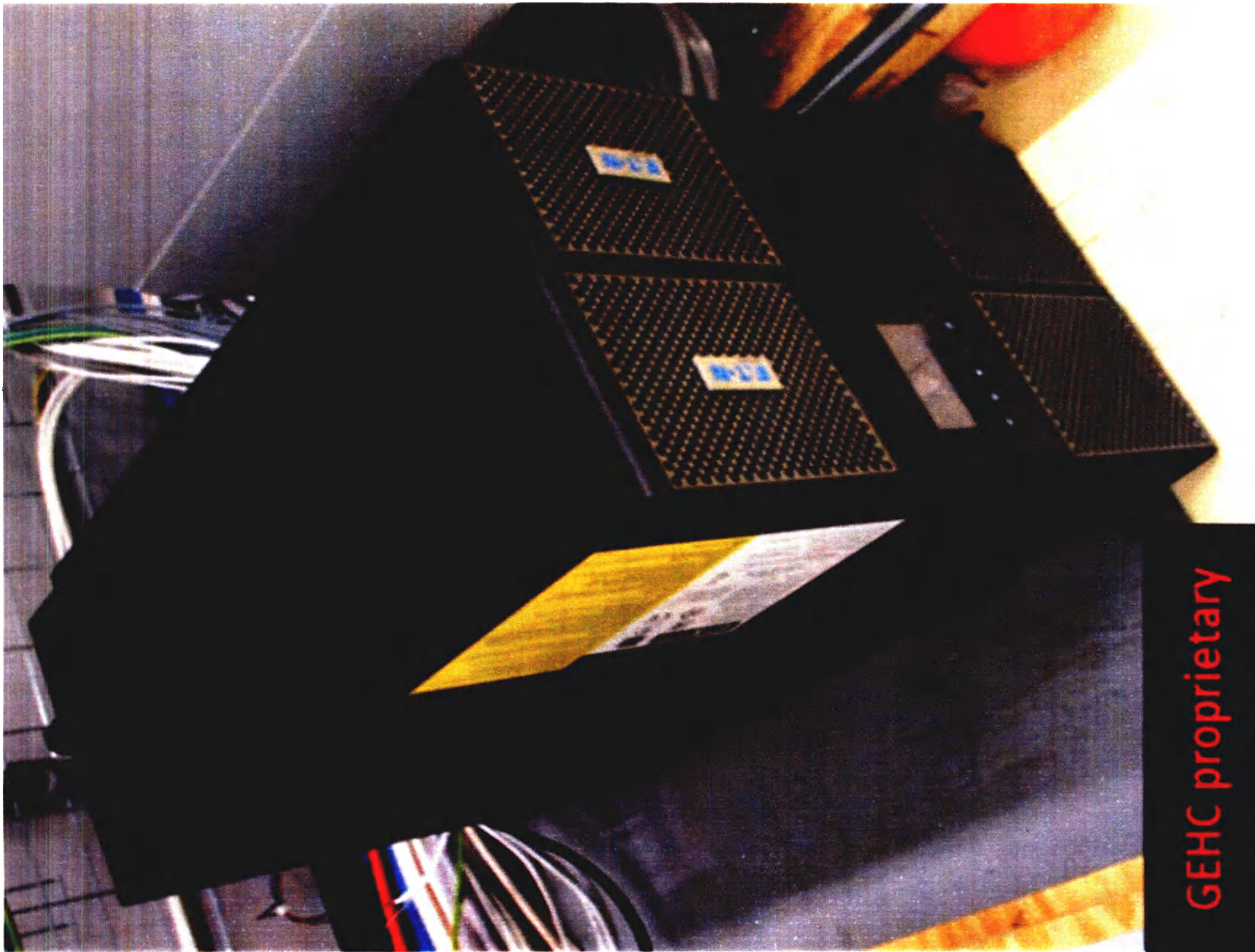
Рисунок 56. Источник бесперебойного питания ангиографической системы (8 кВА).
