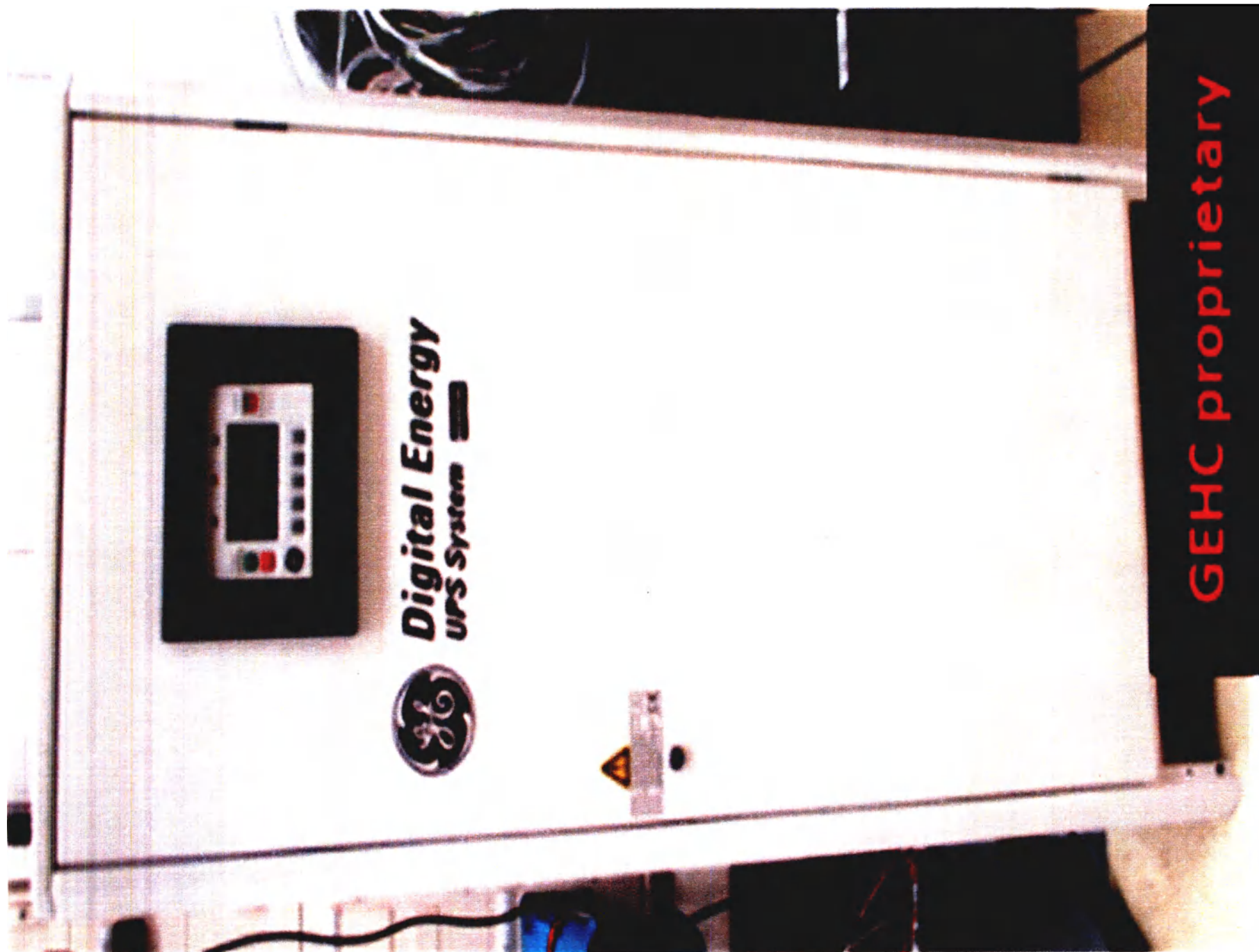
Рисунок 58. Источник бесперебойного питания ангиографической системы (20 кВА).
