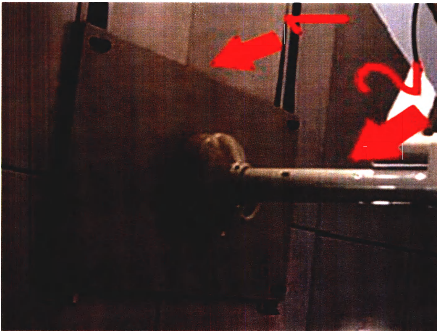
Рисунок 102. Устройства для монтажа рентгенозащитной ширмы и хирургического светильника потолочного крепления (1- пластина, 2- стойка).
