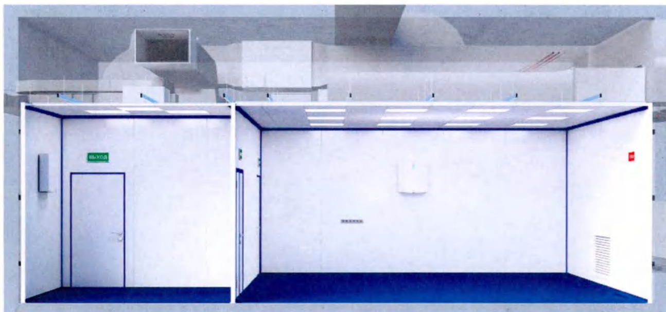
Рисунок 1.4 – Комплекс оборудования «ТИОН» для создания чистых помещений медицинских организаций, исполнение «КО-ТИОН-ЧП-4» для центрального стерилизационного отделения по ГОСТ Р 52539 (пример общего вида компоновки)
