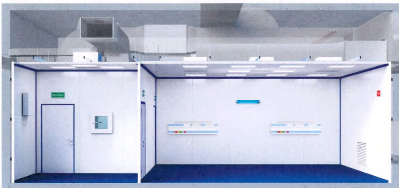
Рисунок 1.3 – Комплекс оборудования «ТИОН» для создания чистых помещений медицинских организаций, исполнение «КО-ТИОН-ЧП-3» для помещений группы 5 по ГОСТ Р 52539 (пример общего вида компоновки)
