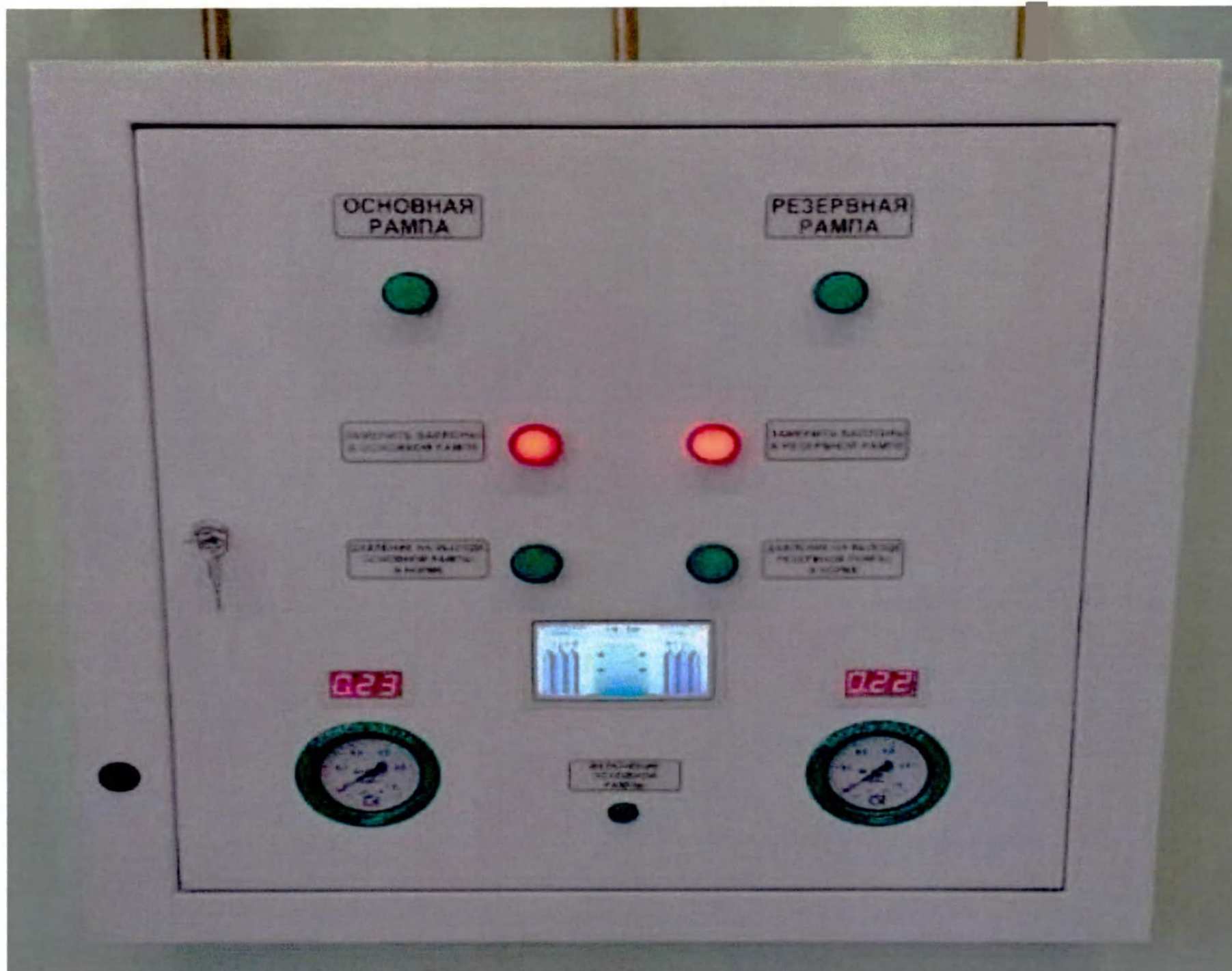
1.4 Щит управления для газобаллонной станции медицинского назначения ЩУГБС по ТУ 9452-005-93204178-2010, производства ЗАО «АТРИУМ», Россия, РУ № ФСР 2010/07866
