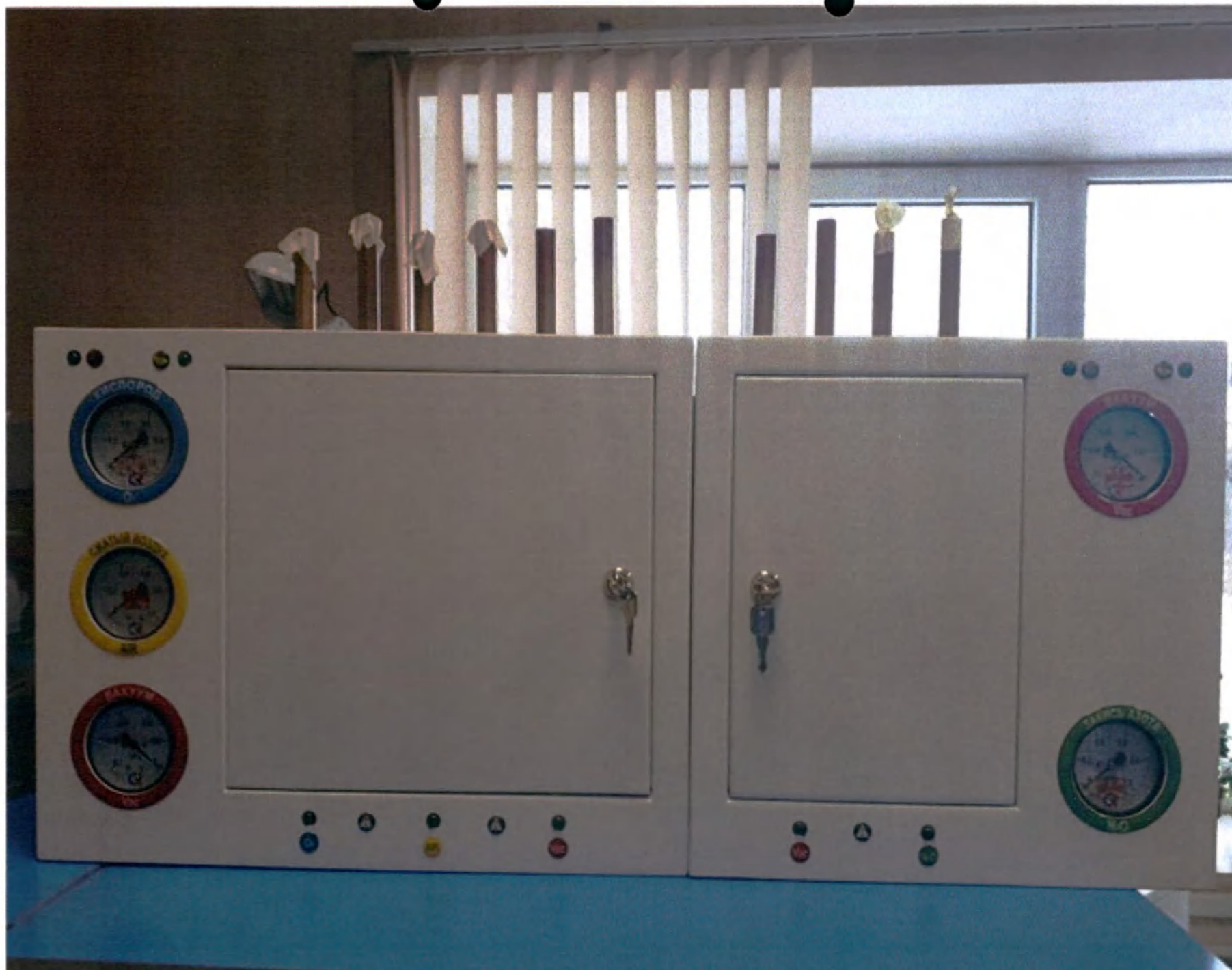
1.6 Коробка газовая этажная с блоком сигнализации КГЭС, ТУ 3645-001-93204178-2010
