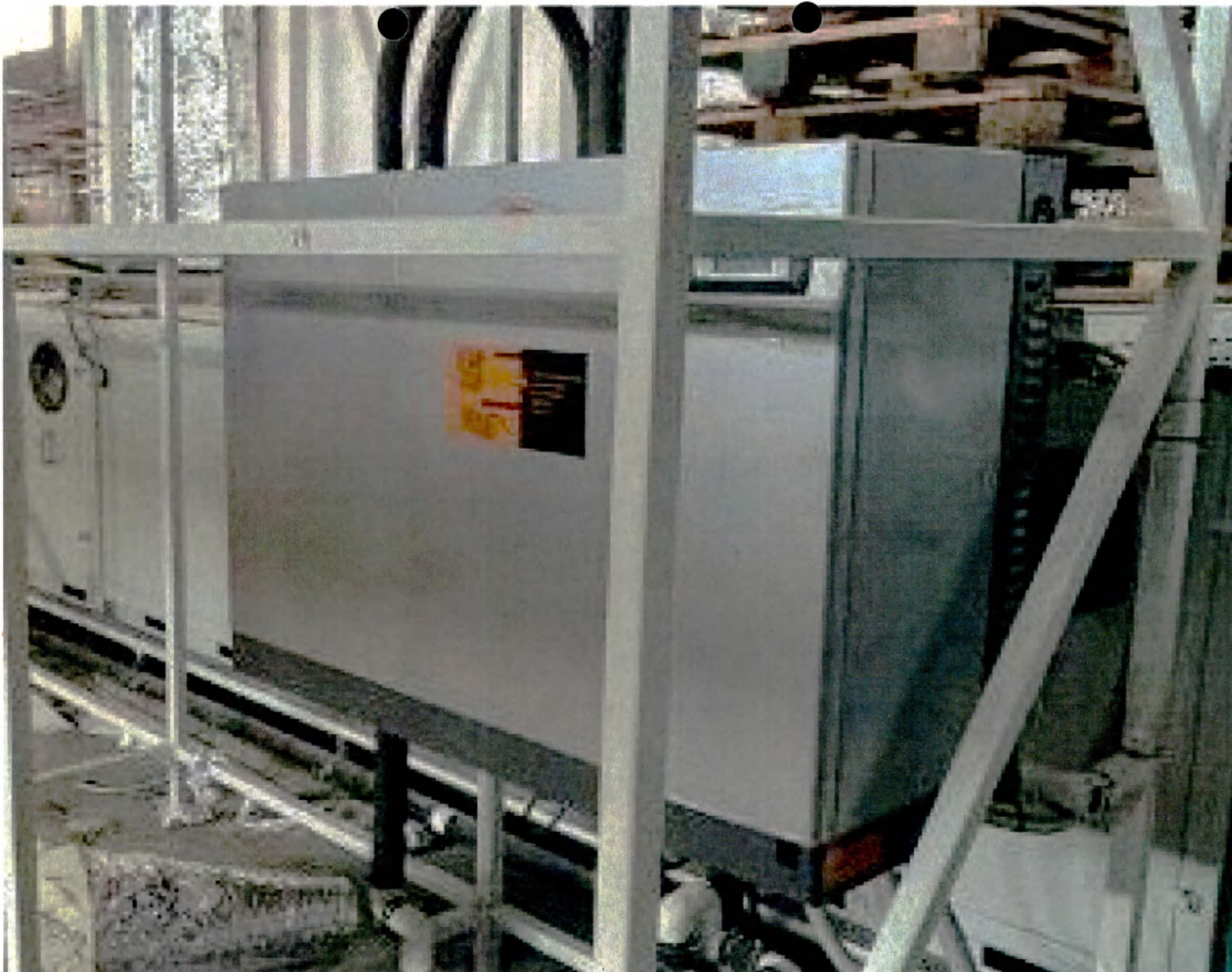
1.2 Пароувлажнитель для приточно-вытяжной системы, производство ООО «ТехноГрупп», Россия
