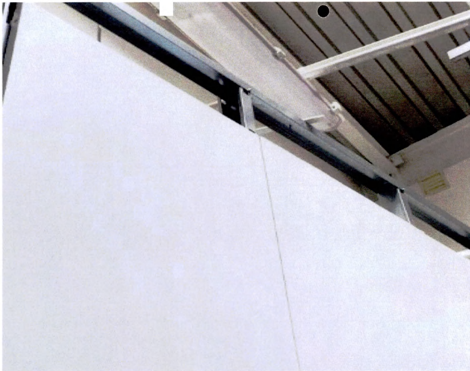
1.6 Перегородка двойная из облицовочных панелей
