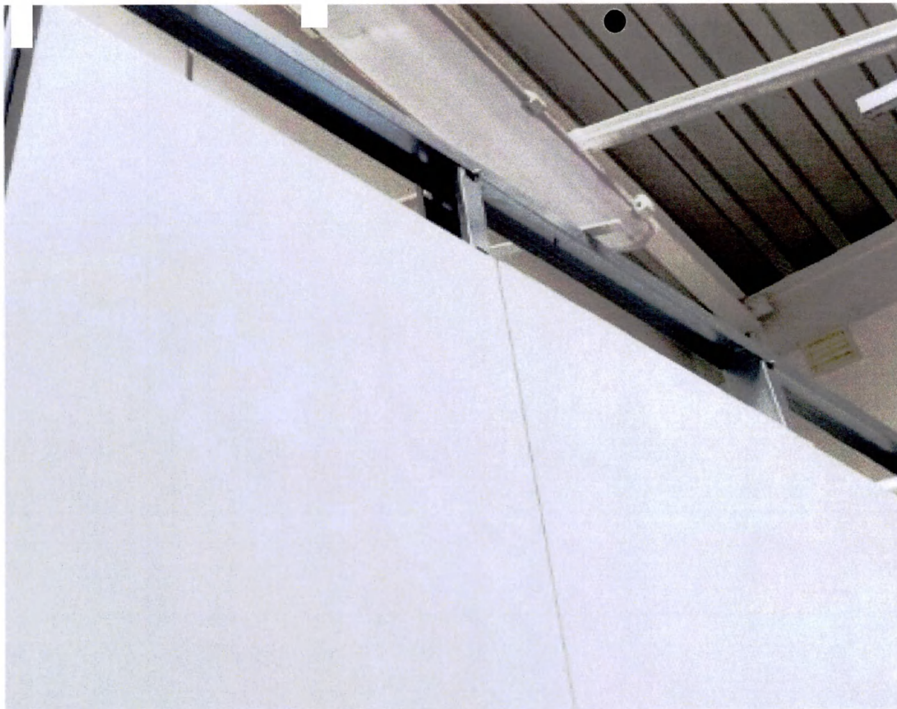
1.7 Перегородка двойная из облицовочных панелей
