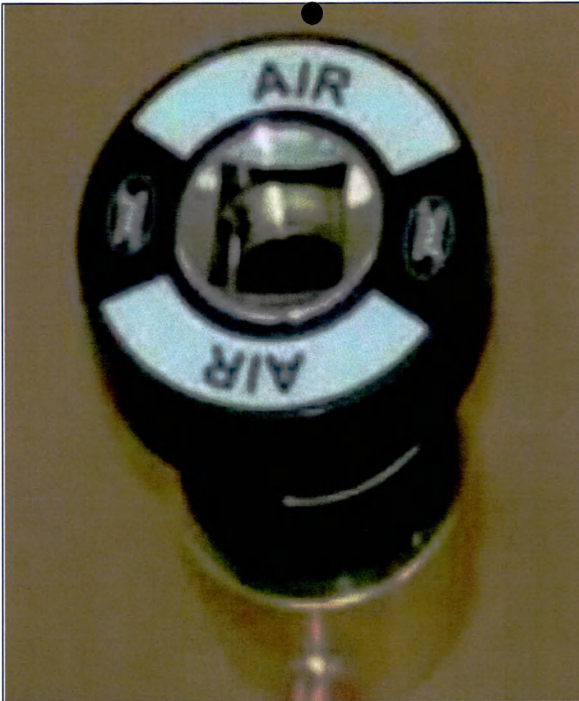
1.3 Клапан газовый КГ со штекером газовым ШГ для оперативного подключения аппаратуры жизнеобеспечения пациентов к системам медицинских газов по ТУ 9452-003-93204178-2010, производства ЗАО «АТРИУМ», Россия, РУ № ФСР 2010/07867
