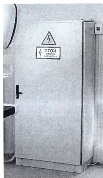
Рисунок 3 – Силовой шкаф
