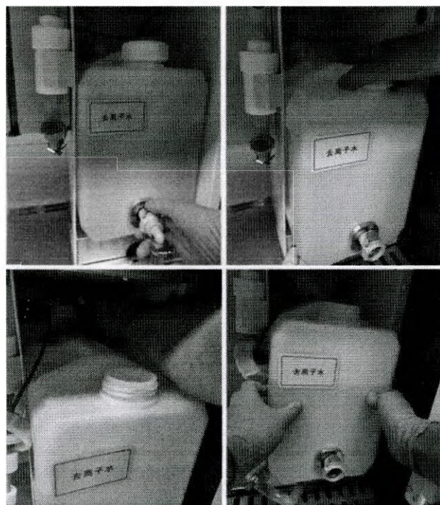
Figure 11.5 Снятие бачка для деионизированной воды
