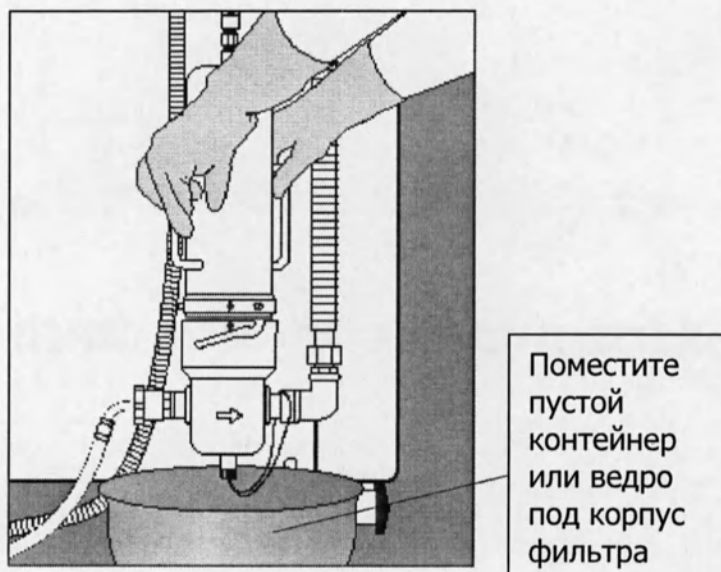
Рис. 69. Установка пустого контейнера под корпусом фильтра
