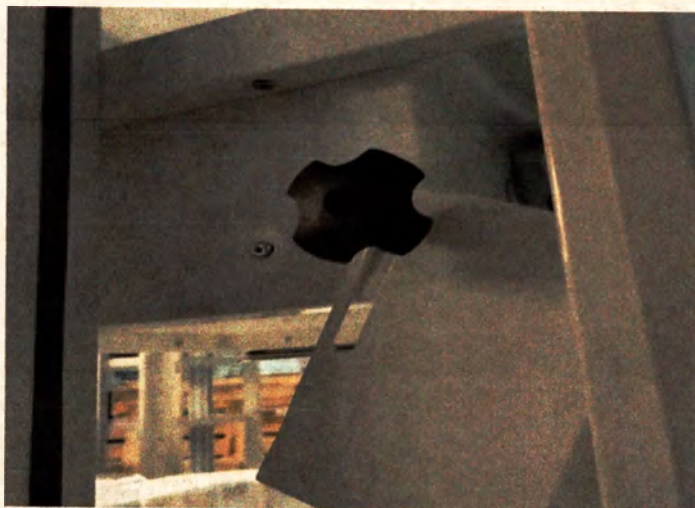
Рисунок 14а - Снятие крышки кабель-канала для подключения оборудования
