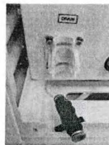
Дренажное отверстие готово к сливу воды
