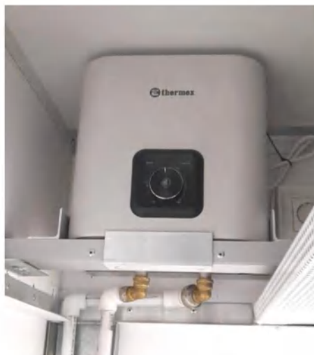
Рис. 53 «Электрический водонагреватель, выключатель и индикатор водонагревателя»
