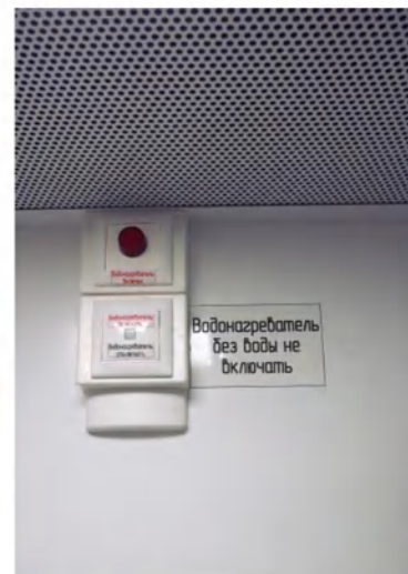
Рис. 53 «Электрический водонагреватель, выключатель и индикатор водонагревателя»
