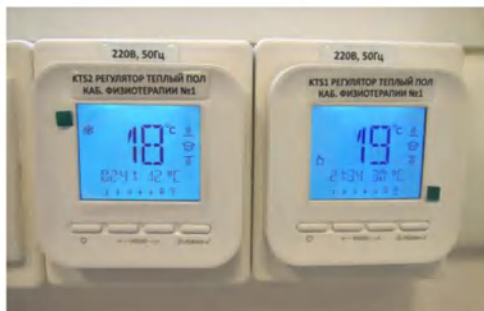
Рис. 47 «Термостат теплого пола»
