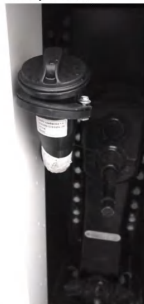
Рис. 6 «Резервный ввод питания для подключения к внешнему источнику питания»
