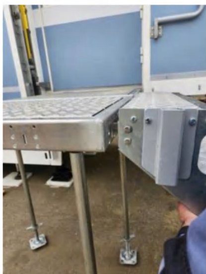
Рис. 21 «Пазовые отверстия площадки»
