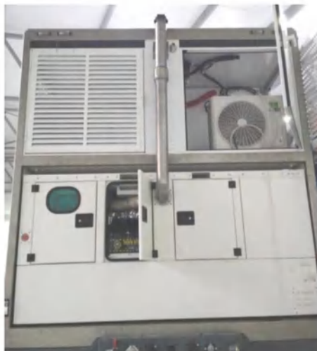
Рис. 40 «Внешние блоки системы кондиционирования»
