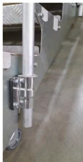
Рис. 22 «Монтаж перил лестницы»
