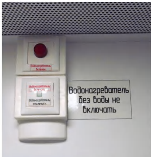
Рис. 58 «Выключатель водонагревателя и индикатор»
