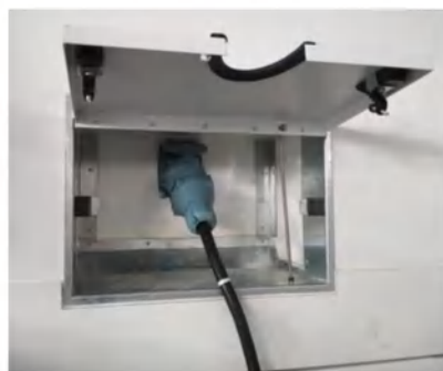
Рис. 14 «Электропитание от внешнего источника»
