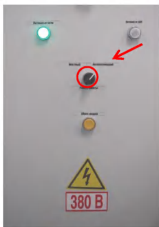
Рис. 33 «Переключатель «Режим работы» в положении «Автоматический»»
