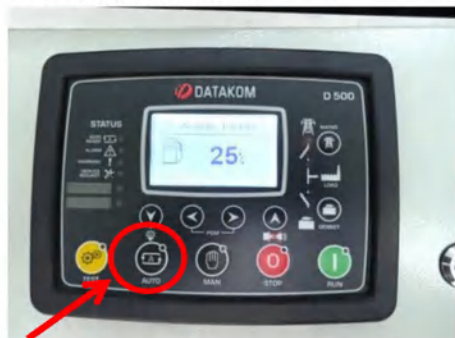
Рис. 35 «Панель контроллера ДГУ, режим AUTO»
