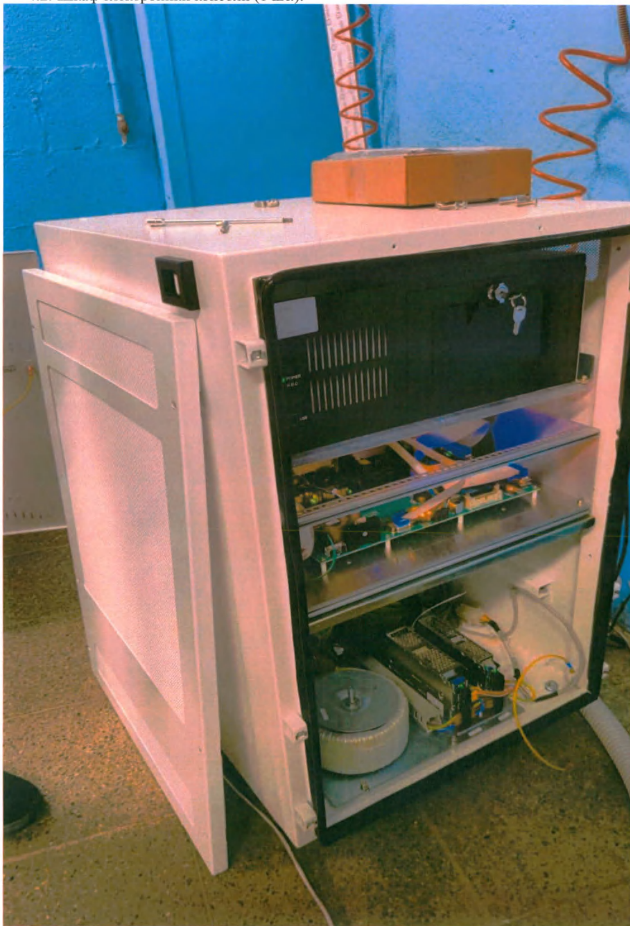
4.2. Шкаф электроники консоли (1 шт.).
