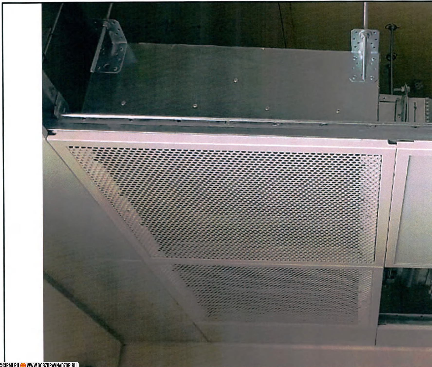
40. Камера статического давления (КСД), производства ООО «АнтенМед», Россия. (для вариантов исполнения модуля «МКМ-МО», «МКМ-МИТР»)
