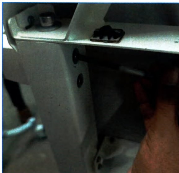
Рис. 5.12 – Монтаж полки для оборудования
