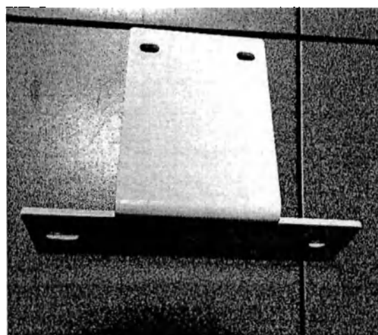
Кронштейн крепления колонны к стене
