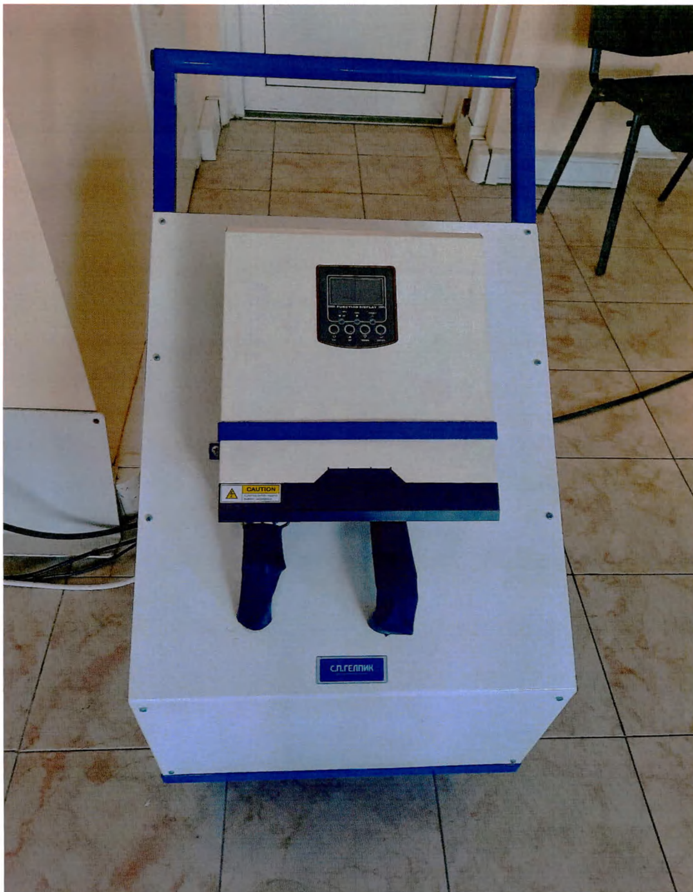
Рис 31. - Накопитель энергии, модель ЛЖКМ.9442.041.102, производства ООО «С.П.ГЕЛПИК», Россия;
