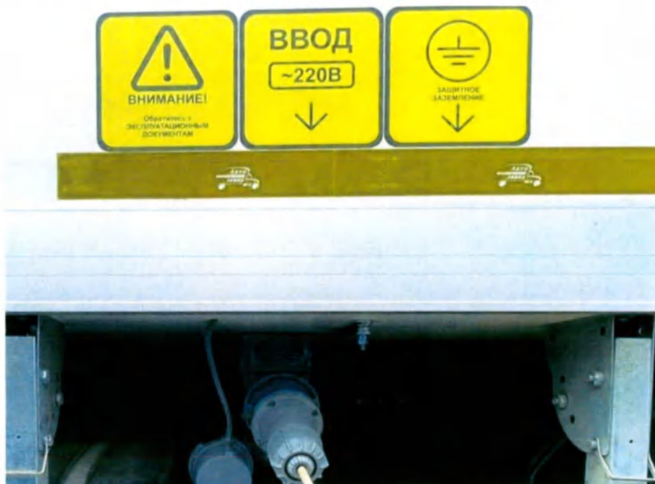
Вводная вилка силового разъема с подключенной кабельной розеткой и зажим защитного заземления с маркировкой на борту Модуля.
