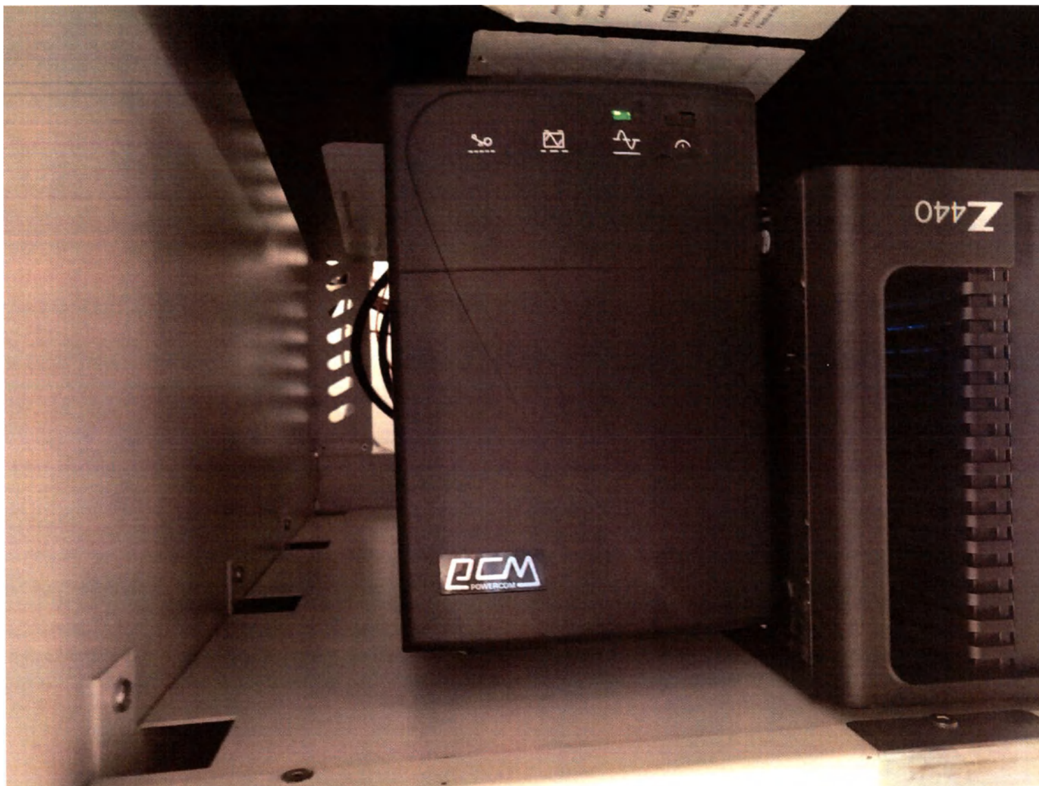
Фото 73. Источник бесперебойного питания (ИБП) линейно-интерактивный
