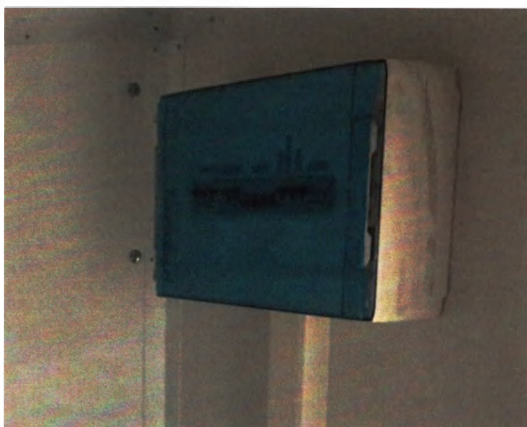
Рисунок 188 Щиток питания (в транспортировочной пленке)
