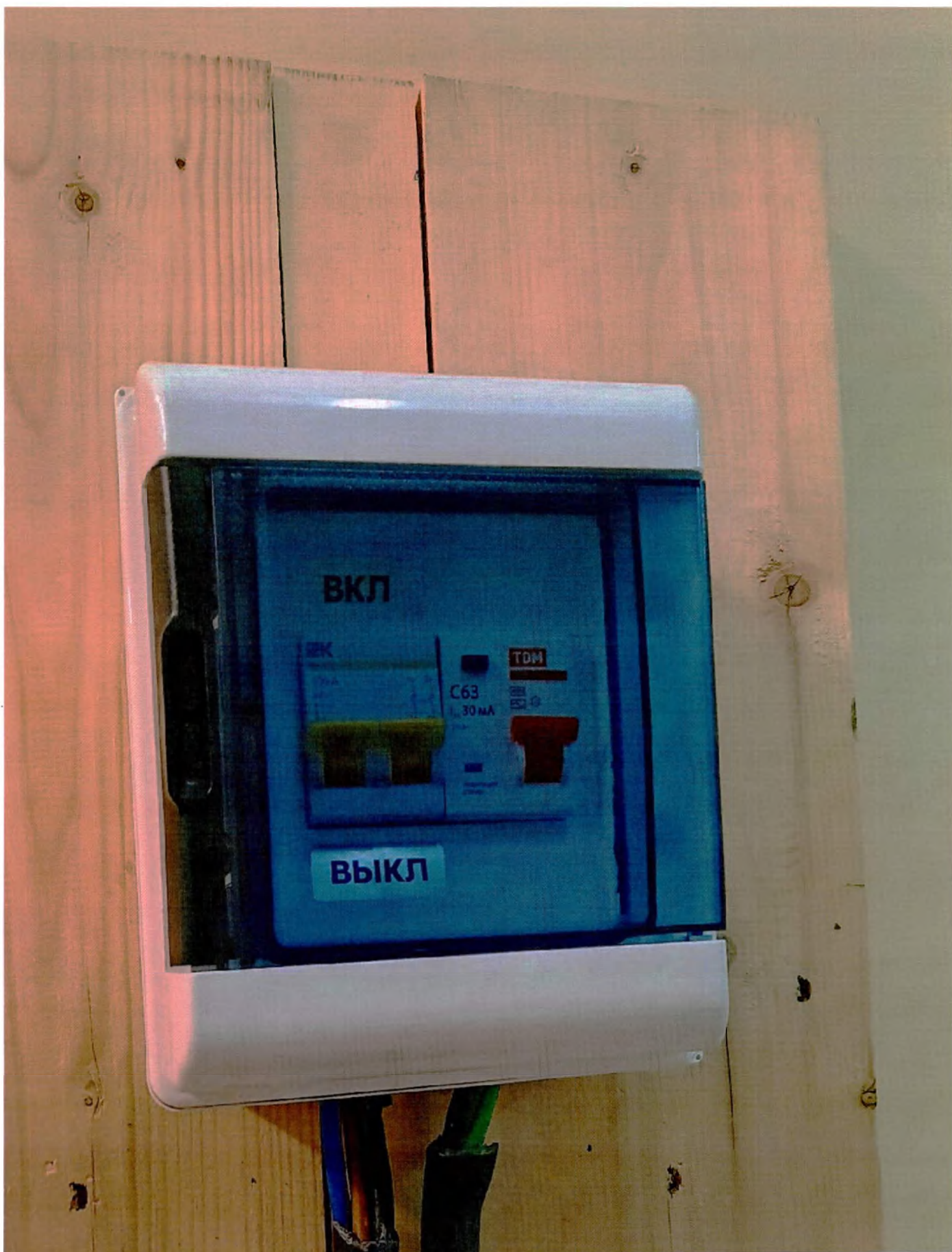
Рис 26. Щит электроснабжения, модель ЛЖКМ.566112.003, производства ООО «С.П.ГЕЛПИК», Россия
