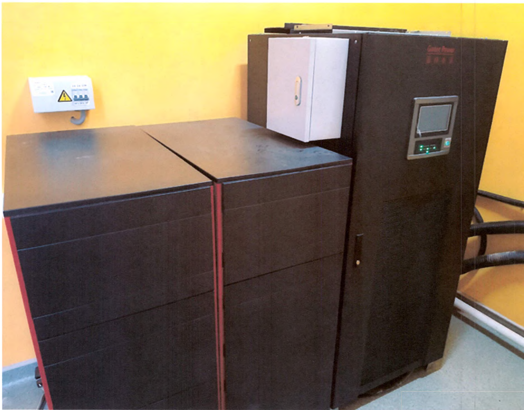
Источник бесперебойного питания на всю систему с комплектом аккумуляторов, модель Giant EL 33 100 kVA
