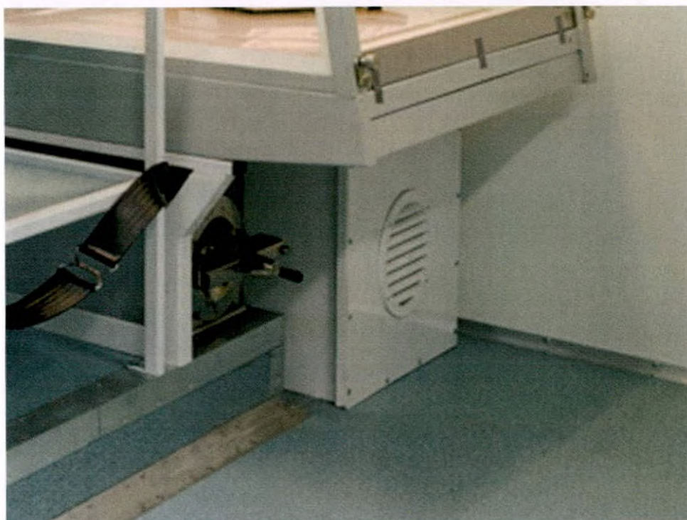
Приточный фильтровентиляционный блок
