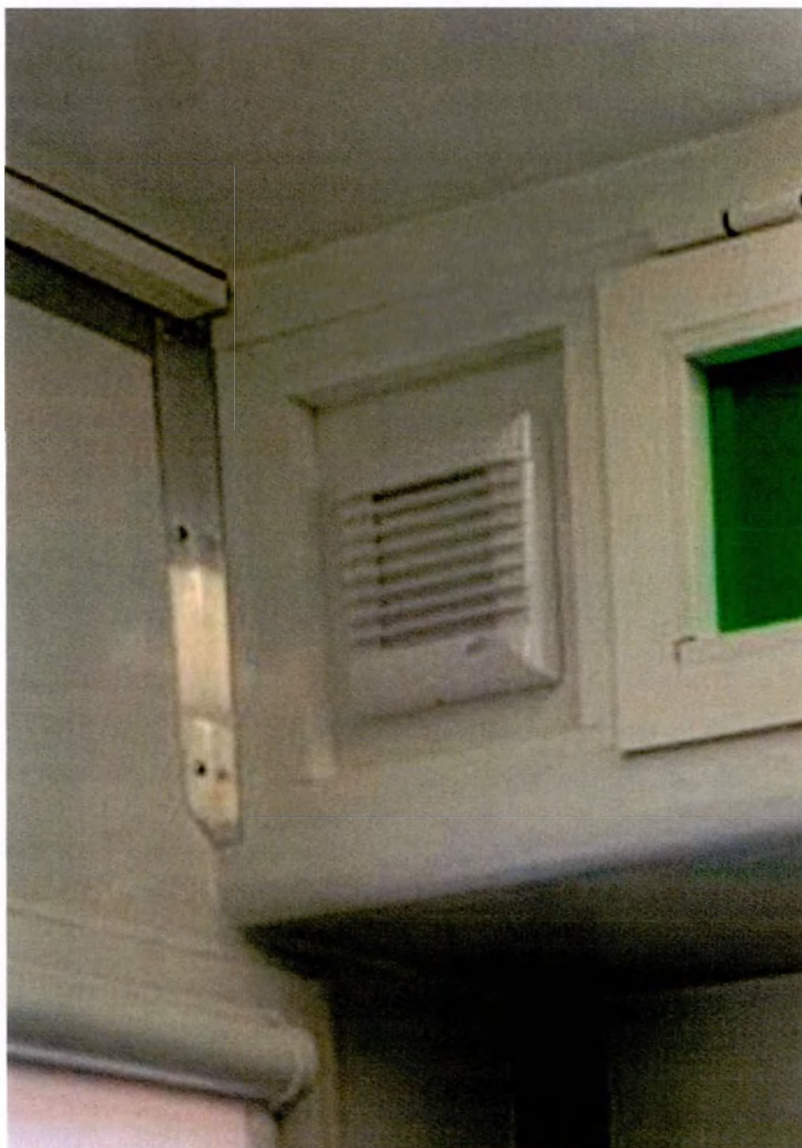
Вентилятор вытяжной
