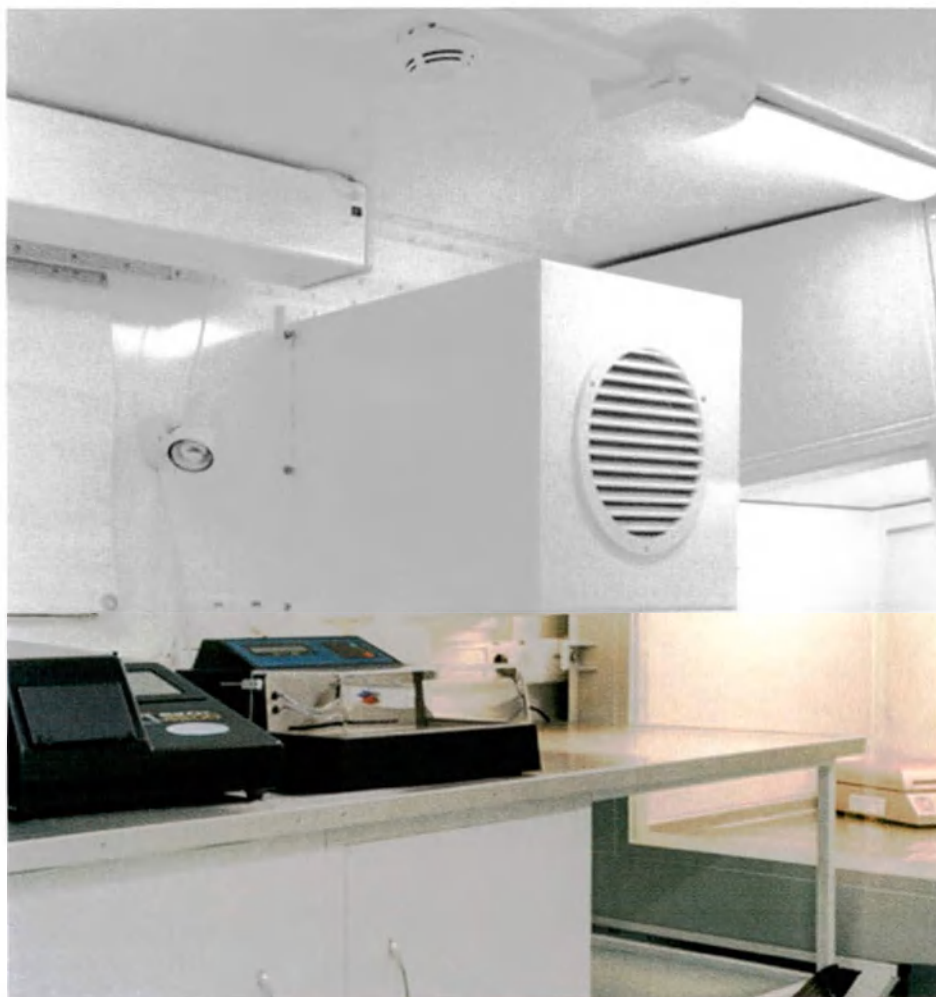
Вытяжной фильтровентиляционный блок
