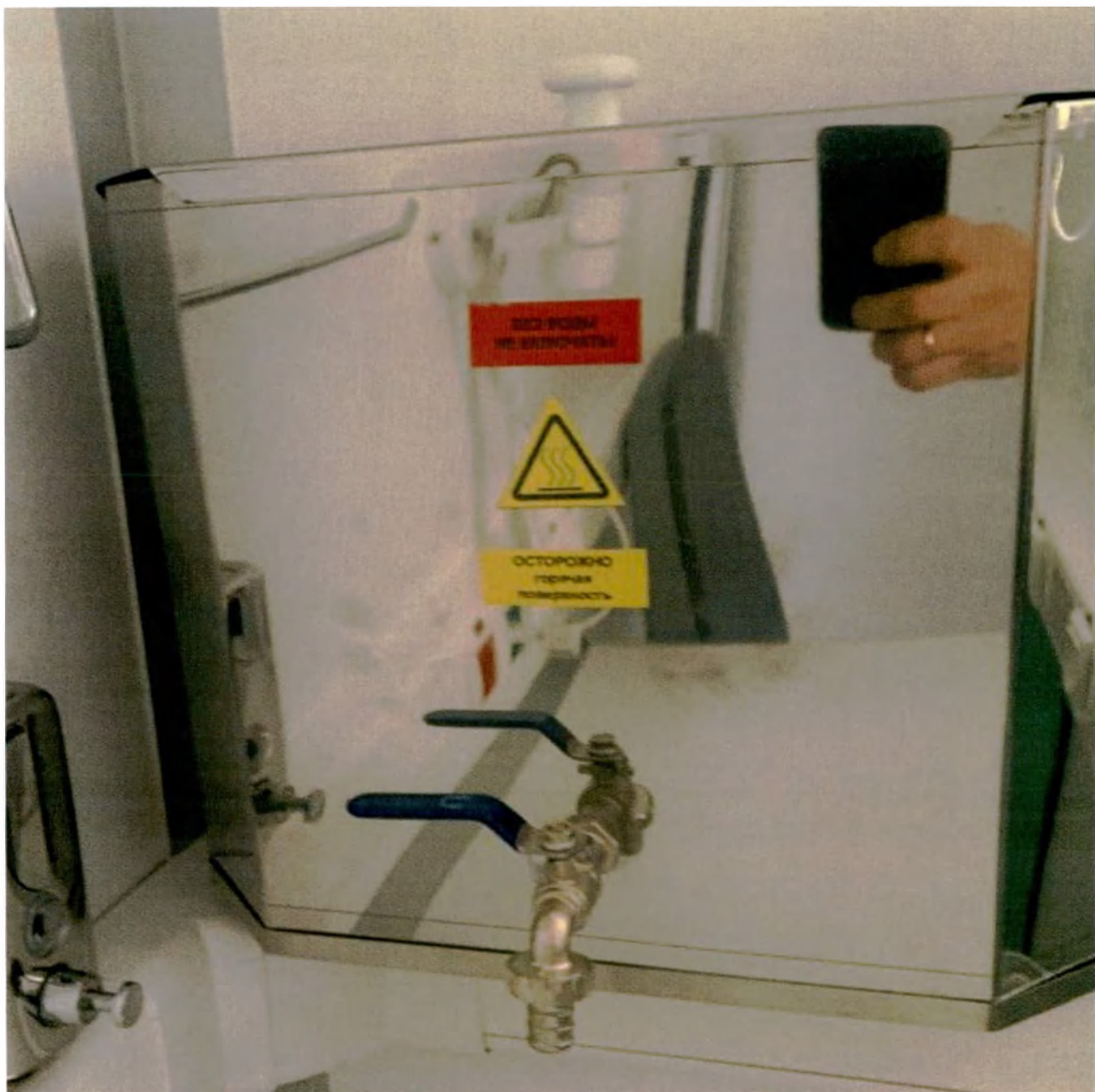
Электроводонагреватель аккумуляторный
