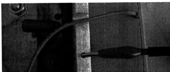
Рисунок 3.8 – Место подключения перемычки замыкающей к корпусу
