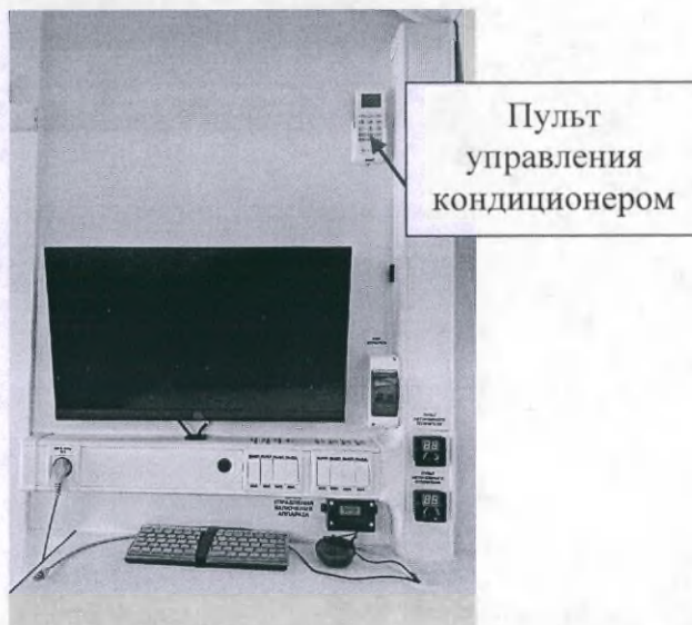
Рис. 69 – Пульт управления кондиционером в рабочем салоне (маммография)
