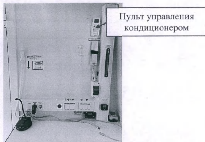
Рис. 71 – Пульт управления кондиционером в рабочем салоне (флюорография)
