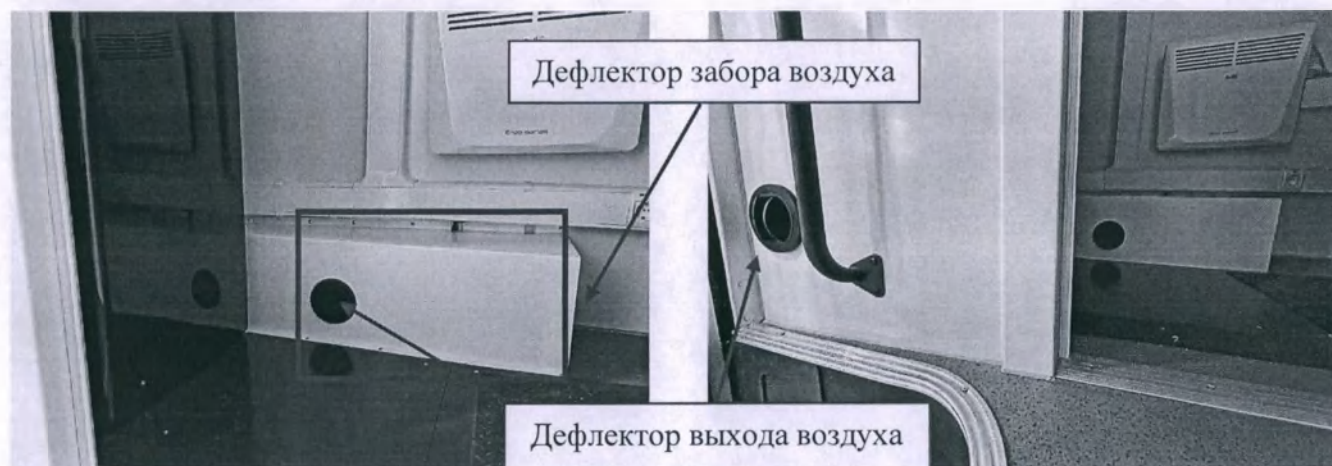
Рис. 50 - Отопитель автономный в процедурном кабинете (флюорография)
