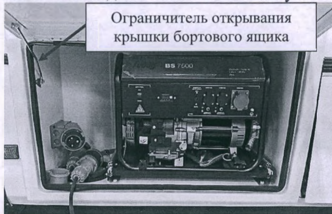
Рис. 78 - Генератор (расположение в комплексе)
