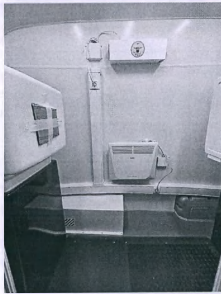
Рис. 67 - Расположение конвектора в процедурном кабинете (флюорография)
