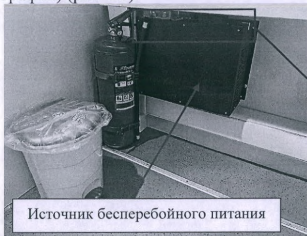
Рис. 26 – Источник бесперебойного питания в процедурном кабинете (маммография)
