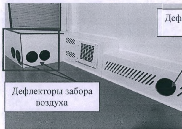
Рис. 48 - Отопитель автономный в процедурном кабинете (маммография)
