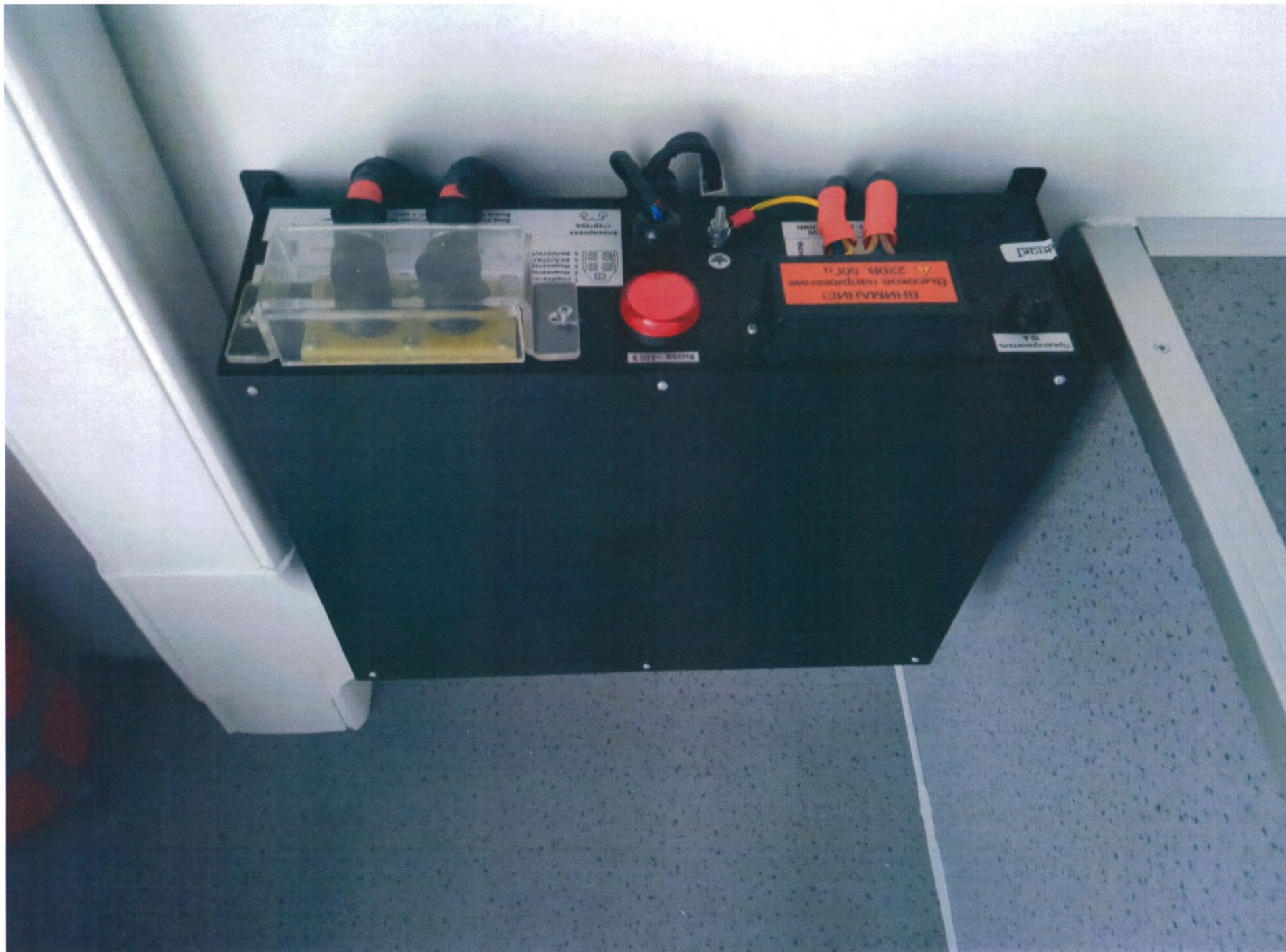
Рисунок 25 – Источник бесперебойного питания
