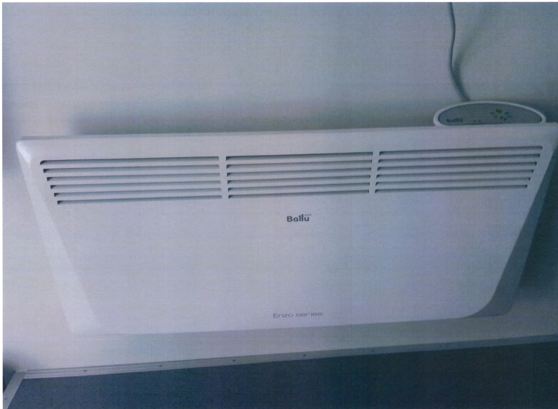
Рисунок 21 – Конвектор (мощность 2,5 кВт)
