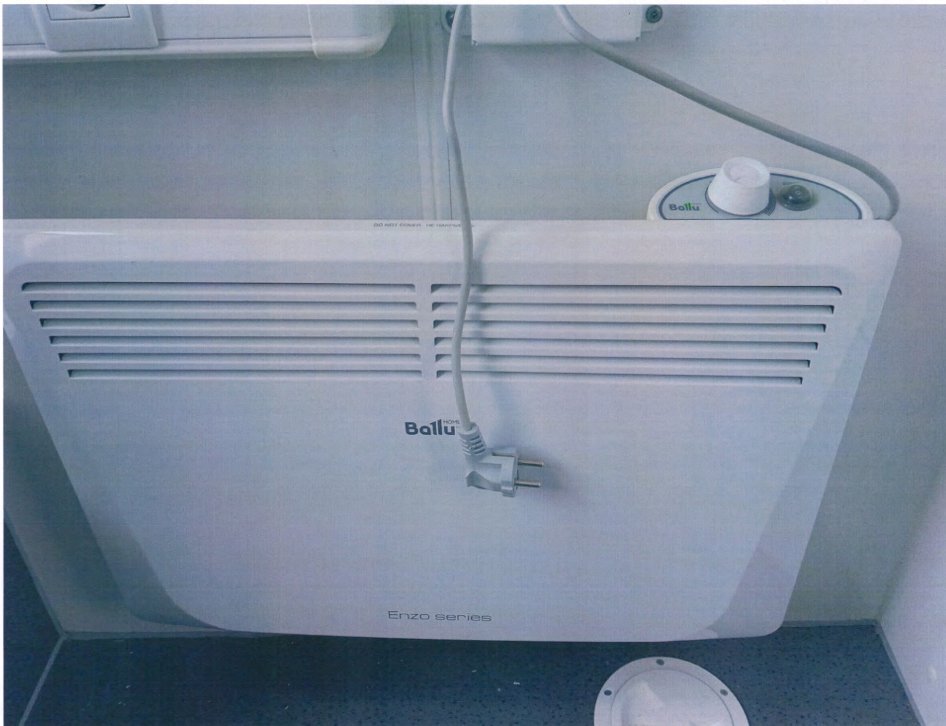
Рисунок 20 – Конвектор (мощность 1,5 кВт)
