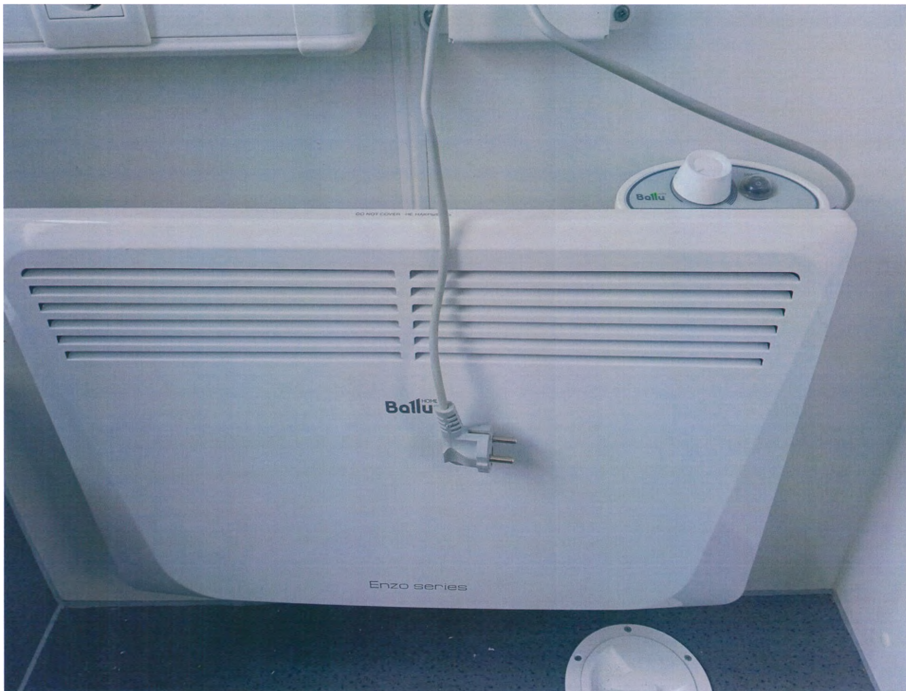
Рисунок 19 – Конвектор (мощность 0,5 кВт)
