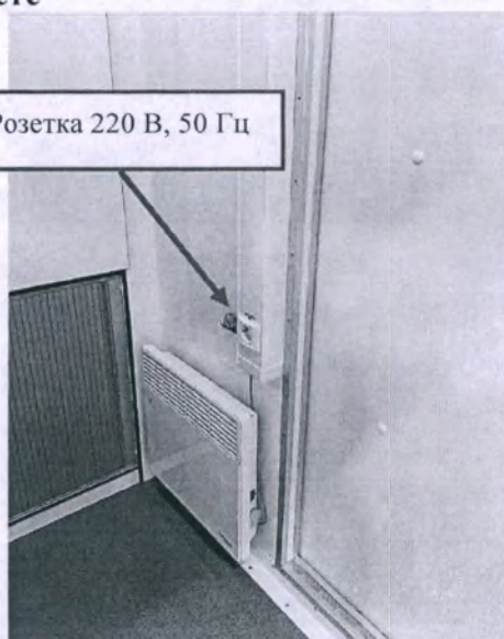
Рис. 17 - Розетки 220 В, 50 Гц в тамбуре
