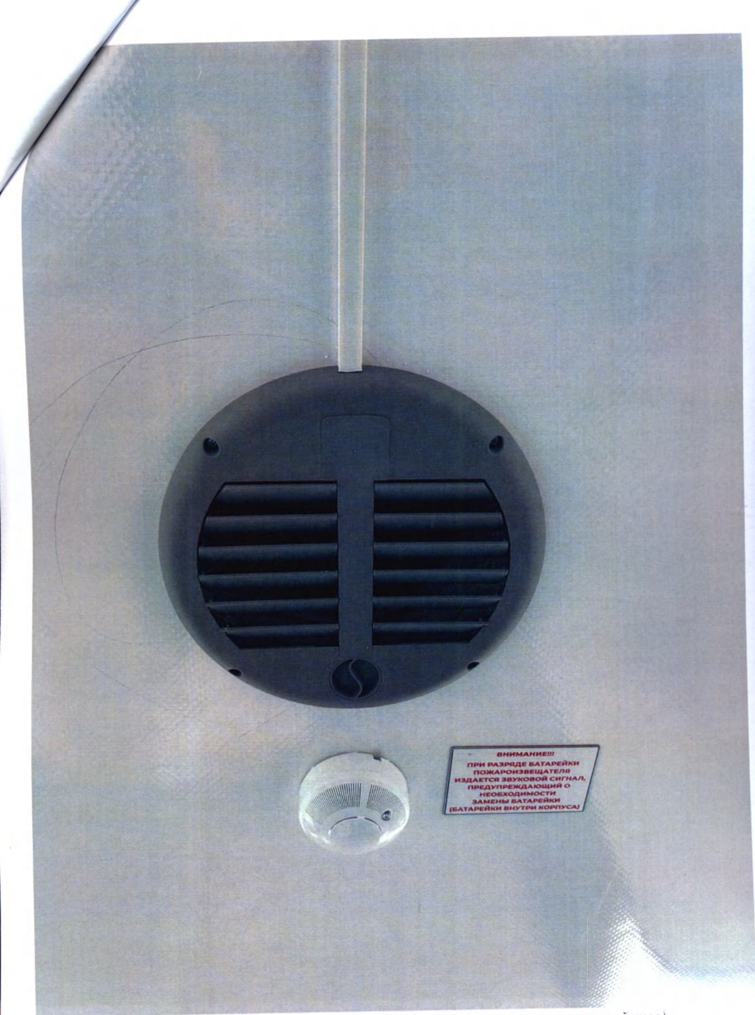
Рисунок 7 – Тамбур(извещатель пожарный, фильтровентиляционное устройство).
