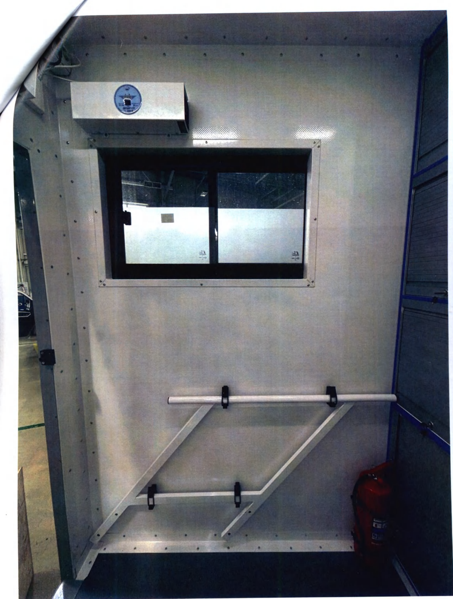
Рисунок 5 –Тамбур(окно, облучатель-рециркулятор)
