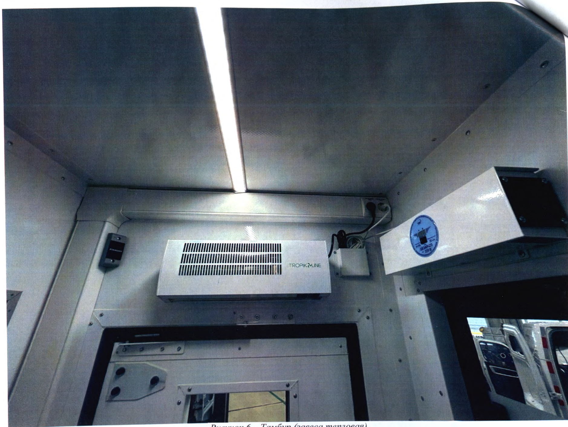
Рисунок 6 – Тамбур (завеса тепловая).
