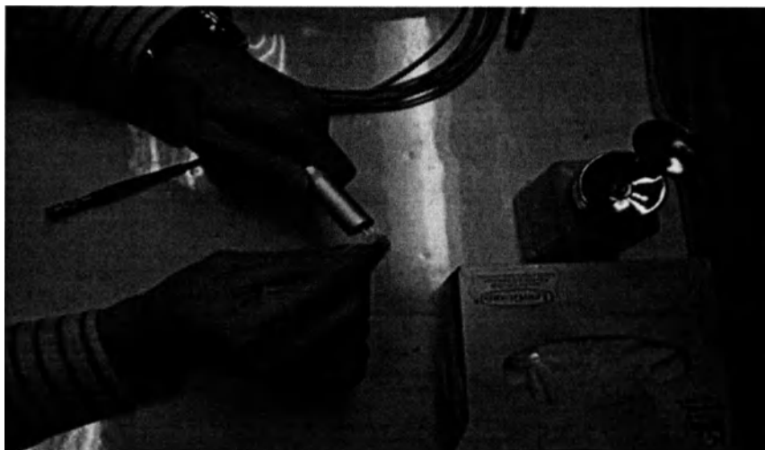
Рисунок 5.22 (b) Очистка оптоволоконна
