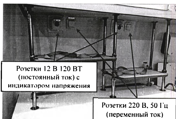
Рис.8 - Розетки по левому борту в медицинском отсеке №2
