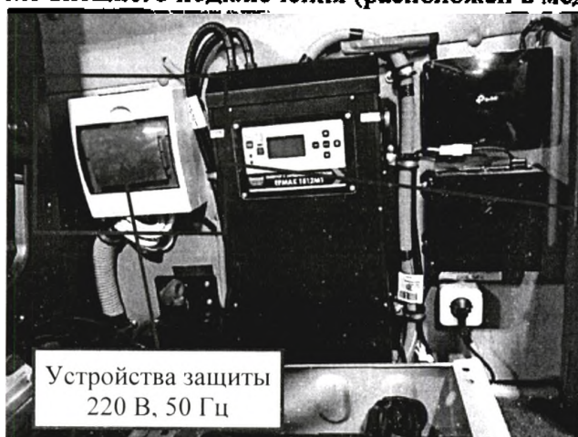
Рис.21 - Бокс с автоматами защиты и реле переключения на перегородке в кабине комплекса
