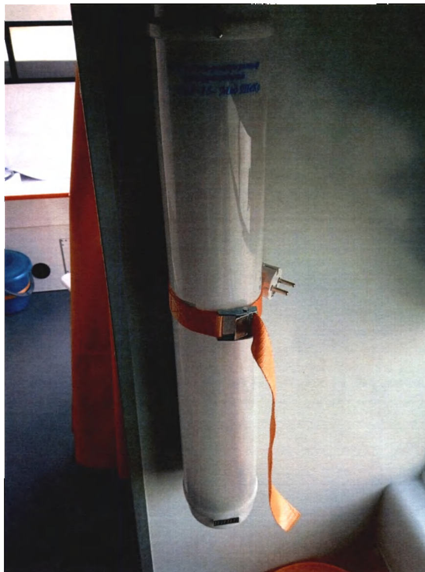
Рисунок 61 - Облучатель-рециркулятор бактерицидный закрытого типа с безозоновой бактерицидной лампой для обеззараживания воздуха помещений ЛПУ в отсутствии людей и предотвращения нарастания микробной обсемененности в присутствии людей ОБР 15/30-"Мед ТеКо" по ТУ 9451-004-56812193-2003 Исполнение 1: 1. Облучатель - рециркулятор бактерицидный закрытого типа с безозоновой бактерицидной лампой для обеззараживания воздуха помещений ЛПУ в отсутствии людей и предотвращения нарастания микробной обсемененности в присутствии людей ОБР-15- "Мед ТеКо" в сборе, общий вид
