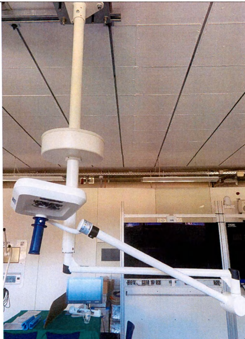
Лампа LEDVISION 65+ для полукарданного подвеса с максимальной силой освещения 90000 люкс (применима к варианту исполнения: VIII. Светильник операционный LEDVISION 65)
