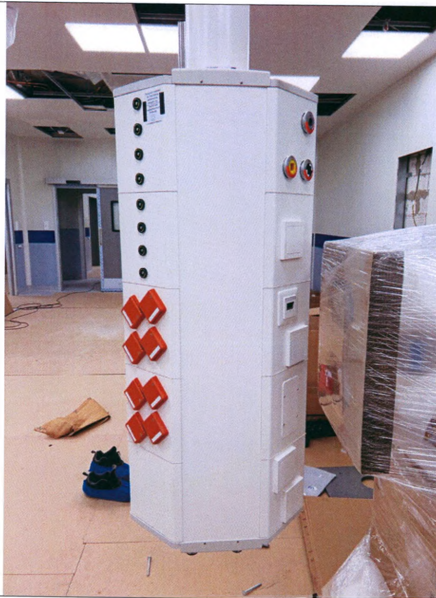
Приборная колонна, на примере варианта исполнения: Приборная колонна без многофункциональной стойки, высота колонны 400 мм (применима к вариантам исполнения: I. Консоль жизнеобеспечения медицинская потолочная ORbiter 90S; II. Консоль жизнеобеспечения медицинская потолочная ORbiter 200M; III. Консоль жизнеобеспечения медицинская потолочная ORbiter 300; IV. Консоль жизнеобеспечения медицинская потолочная ORbiter 600X)
