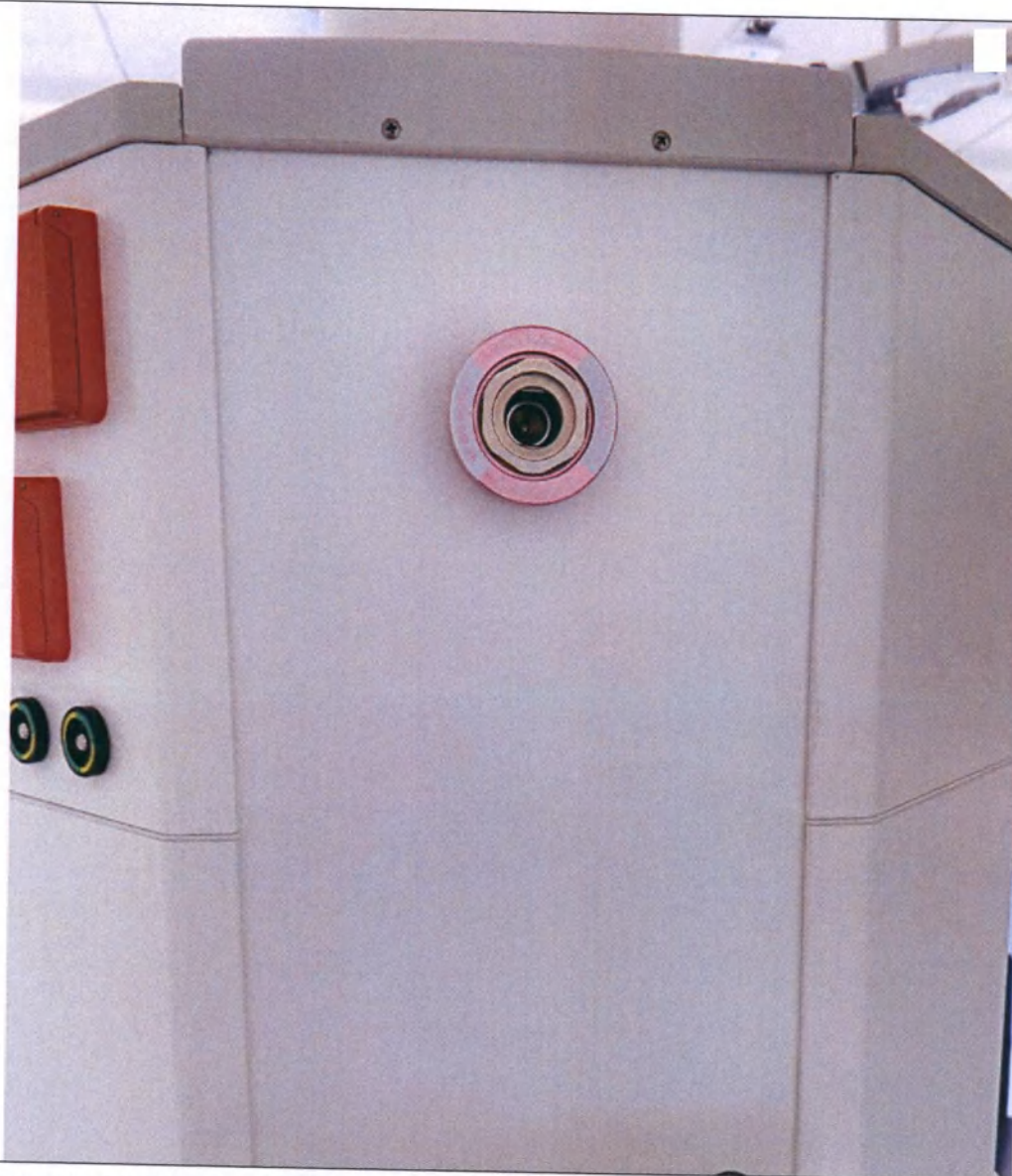
Газовая розетка, на примере варианта исполнения: газовая розетка для выхода отработанного медицинского газа (применима к вариантам исполнения: I. Консоль жизнеобеспечения медицинская потолочная ORbiter 90S; II. Консоль жизнеобеспечения медицинская потолочная ORbiter 200M; III. Консоль жизнеобеспечения медицинская потолочная ORbiter 300; IV. Консоль жизнеобеспечения медицинская потолочная ORbiter 600X)
