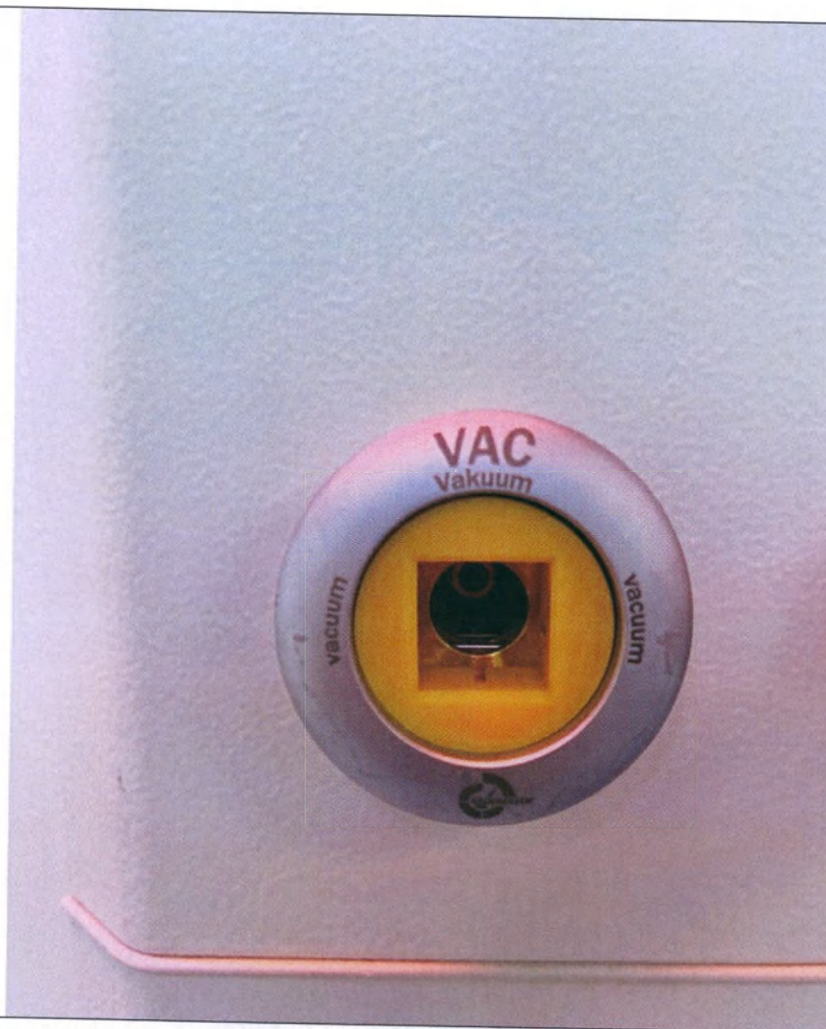
Газовая розетка, на примере варианта исполнения: газовая розетка для вакуума (применима к вариантам исполнения: I. Консоль жизнеобеспечения медицинская потолочная ORbiter 90S; II. Консоль жизнеобеспечения медицинская потолочная ORbiter 200M; III. Консоль жизнеобеспечения медицинская потолочная ORbiter 300; IV. Консоль жизнеобеспечения медицинская потолочная ORbiter 600X)
