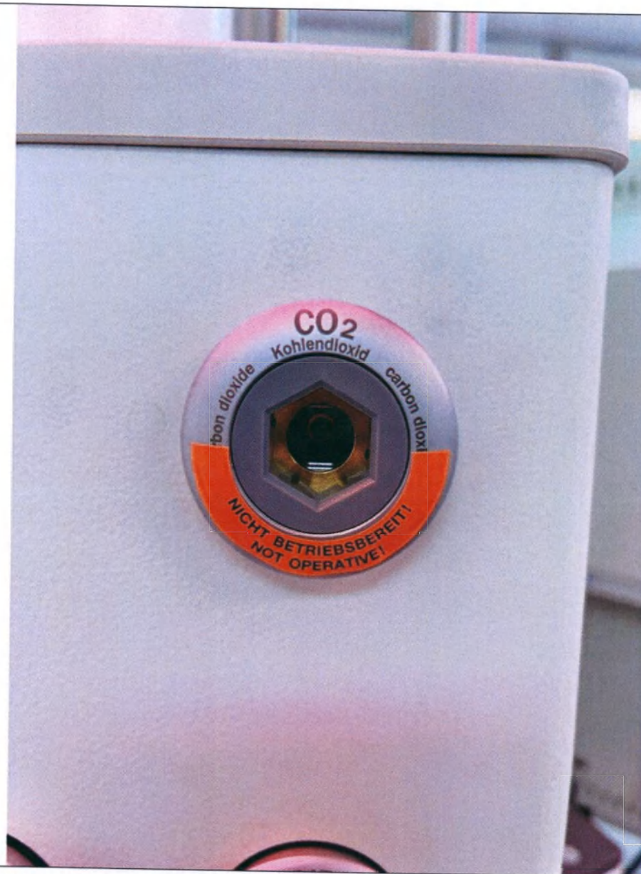
Газовая розетка, на примере варианта исполнения: газовая розетка для углекислого газа (применима к вариантам исполнения: I. Консоль жизнеобеспечения медицинская потолочная ORbiter 90S; II. Консоль жизнеобеспечения медицинская потолочная ORbiter 200M; III. Консоль жизнеобеспечения медицинская потолочная ORbiter 300; IV. Консоль жизнеобеспечения медицинская потолочная ORbiter 600X)
