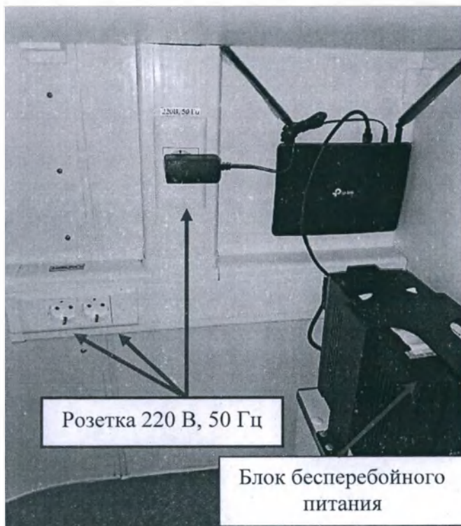
Рис. 8 - Розетки 220В, 50Гц в рабочем салоне и блок бесперебойного питания (вариант исполнения №1)
