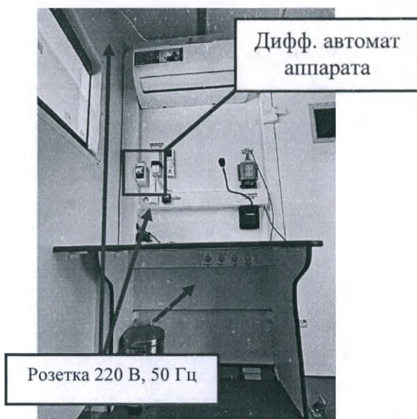
Рис. 10 - Розетки 220В, 50Гц в рабочем салоне (вариант исполнения №2)
