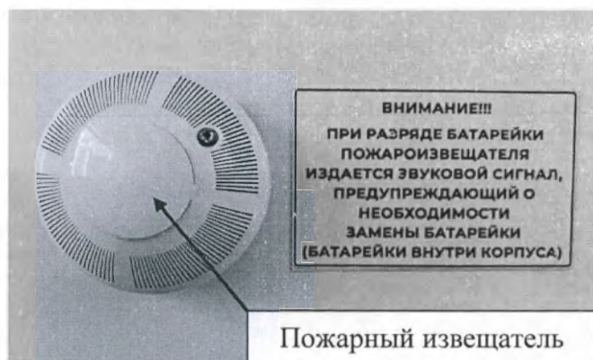
Рис. 77 - Пожарный извещатель отсеков
