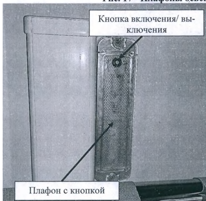
Рис. 18 - Плафон освещения в месте переодевания пациента*
