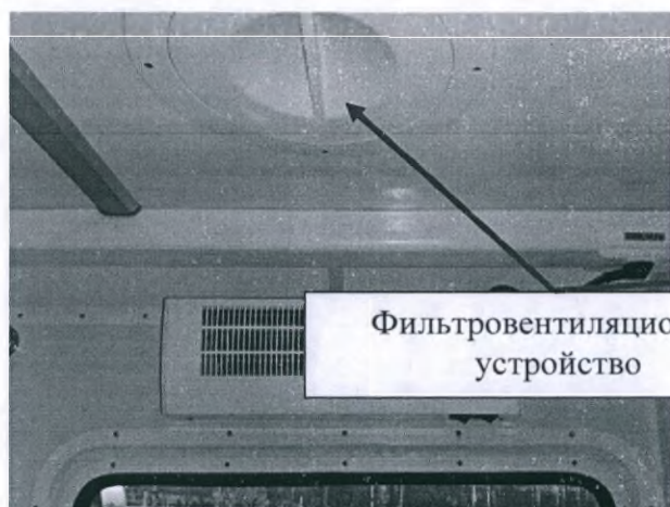
Рис. 29 - Расположение фильтровентиляционного устройства в процедурном кабинете
