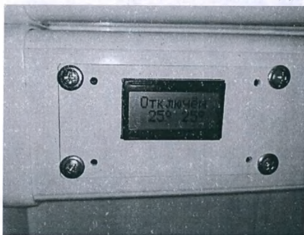
Рис. 73 - Индикаторная панель устройства контроля температуры (кнопка отключена)
