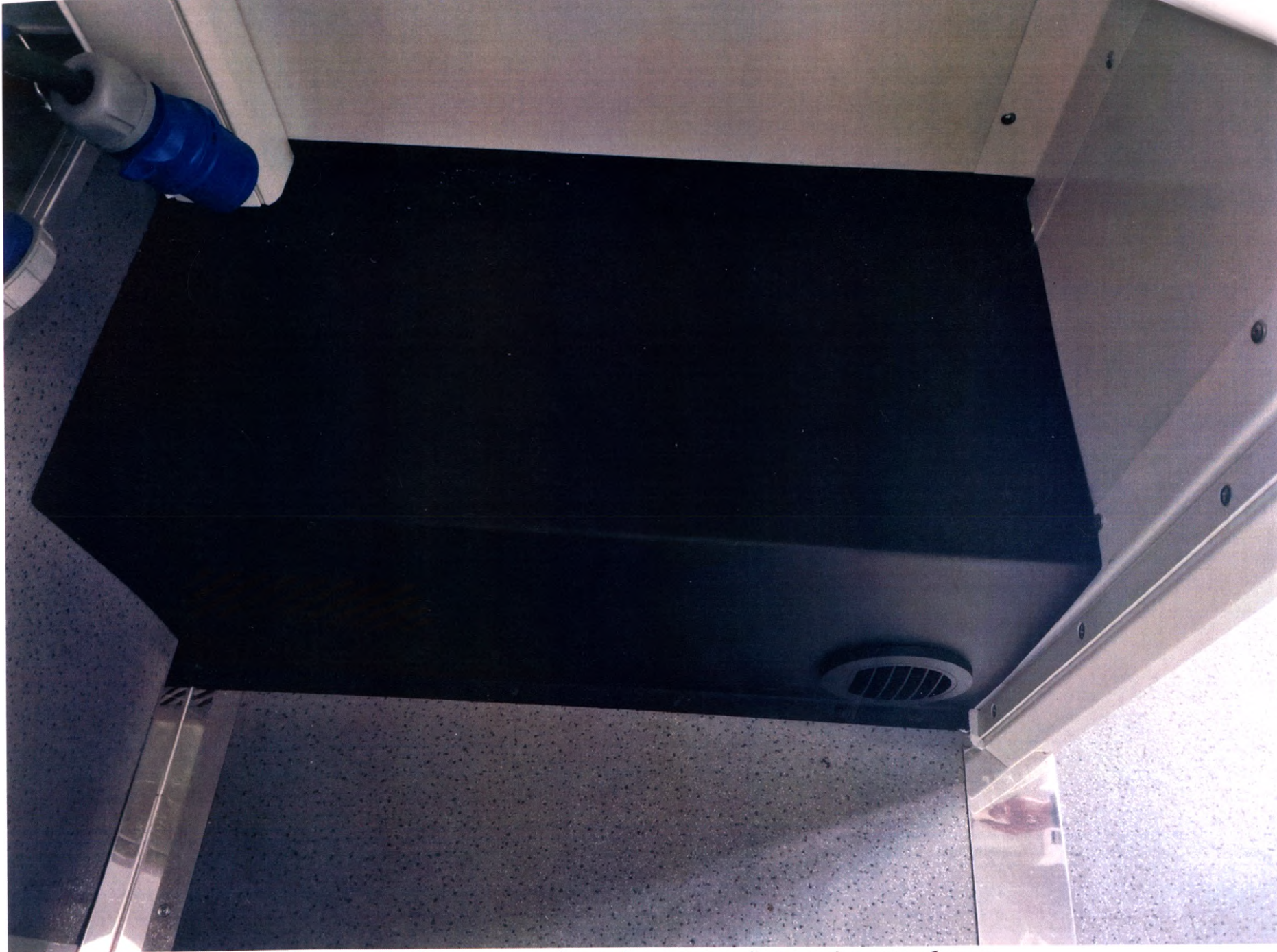
Рисунок 19 – Отопитель воздушный независимый в процедурном кабинете.
