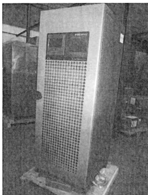
Рисунок 79. Источник бесперебойного питания. Вариант 2.
