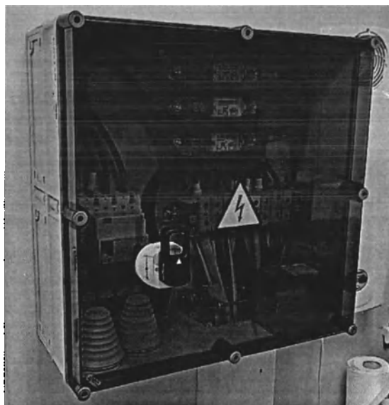
Рисунок 81. Рубильник включения электропитания
