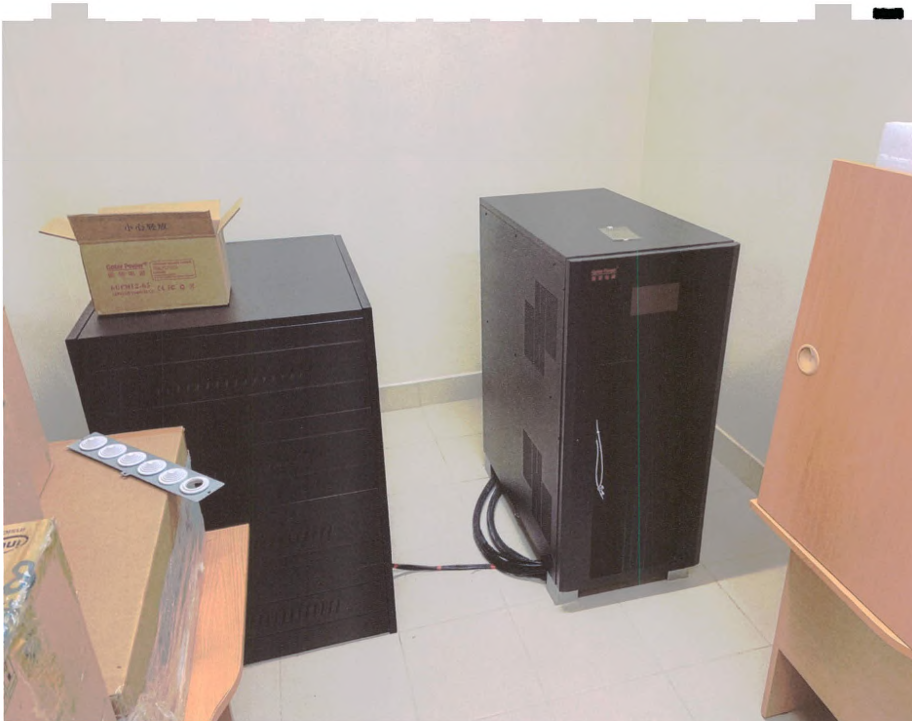
Источник бесперебойного питания на всю систему с комплектом аккумуляторов (на 60 кВА для модели ANATOM 64 Clarity, на 80 кВА для модели ANATOM 64 Precision)
