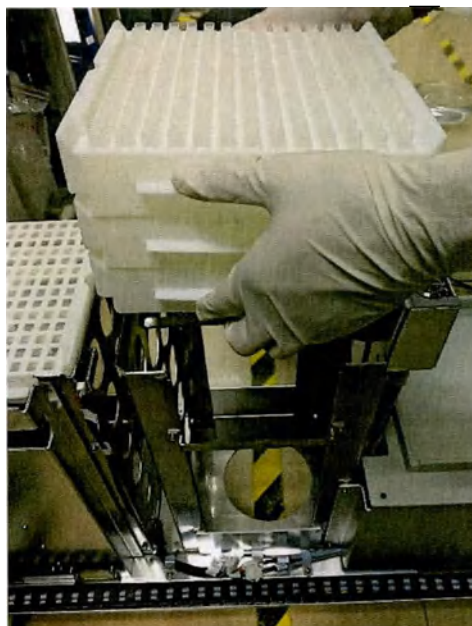
Рис. 4.2-1. Установка нового блока кювет
