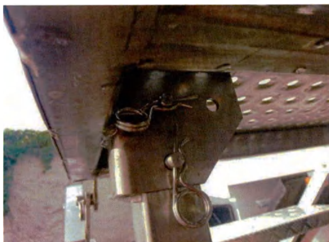
Рисунок 36. Фиксаторы опорных стоек.
