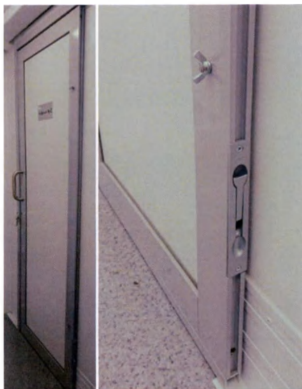
Рисунок 64. Фиксация сдвижных дверей в транспортном положении.
