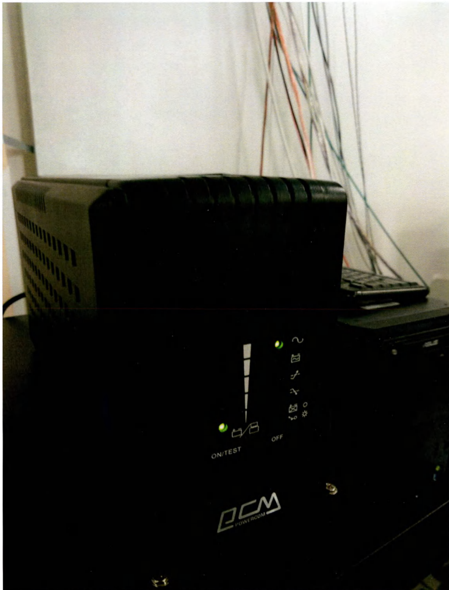
Фотография 87 – Источник бесперебойного питания серии SPT, POWERCOM CO., Ltd Тайвань
